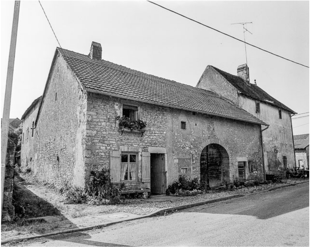
Ferme située rue d'Aval à Chevevrey : façades antérieure et latérale gauche.
