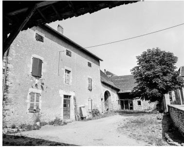
Ferme cadastrée 1973 AB 27 située rue d'Amont à Chenevrey : façade antérieure et dépendances. Phot. Dominique Humbert IVR43_19767000481X
