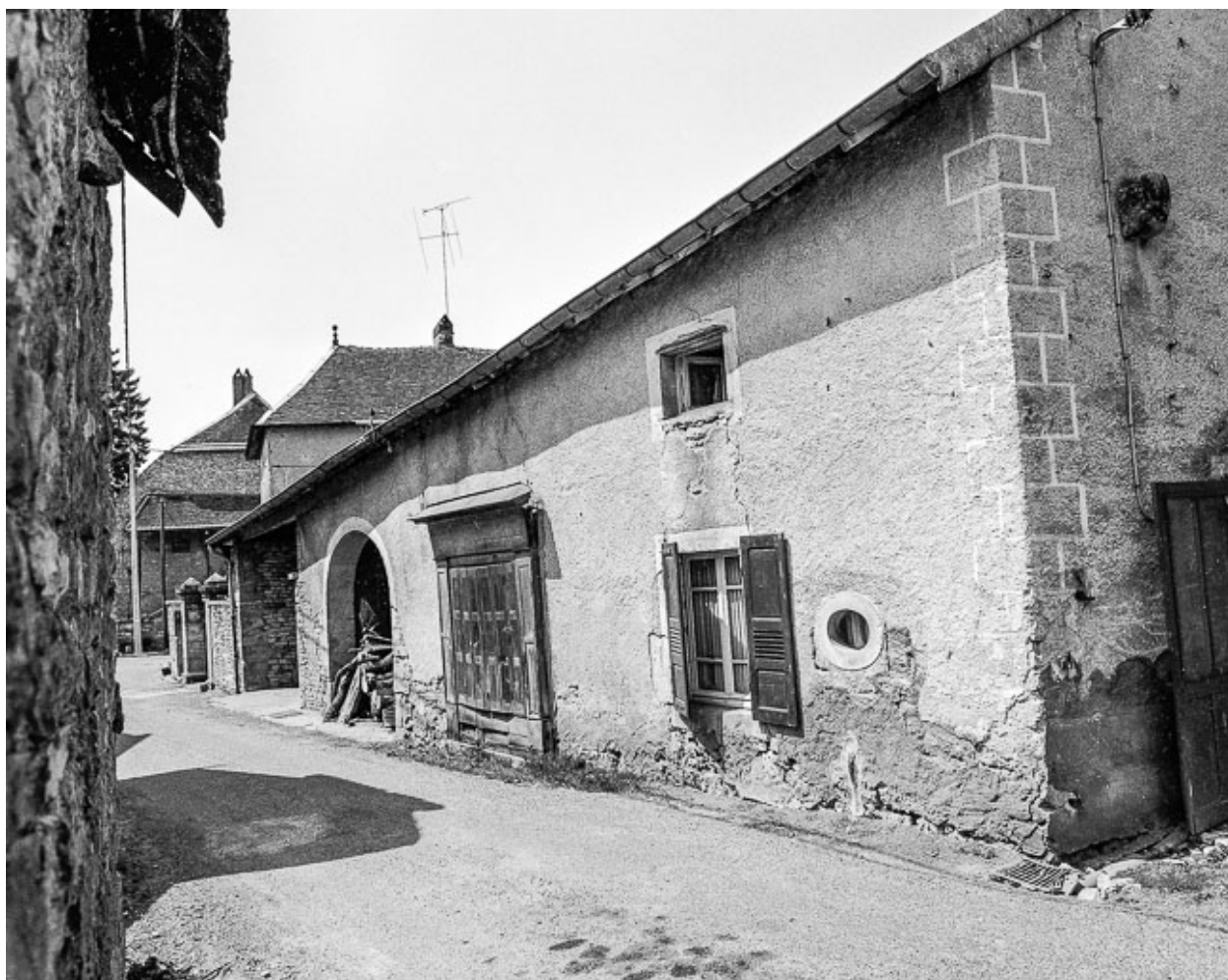
Maison située entre la rue de la Traverse et la ruelle des Escaliers : façade latérale gauche.
