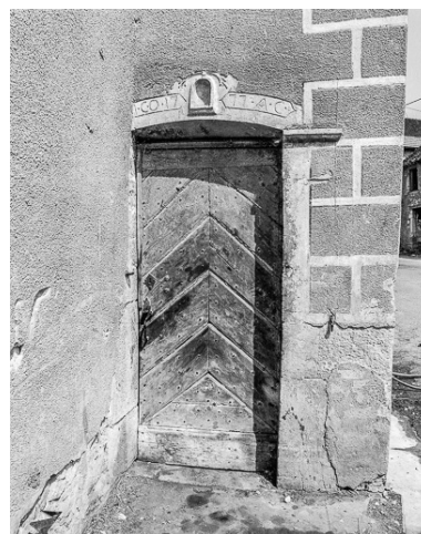
Maison située rue d'Amont à Chenevrey : détail de la porte de la façade antérieure. Phot. Dominique Humbert IVR43_19767000455X
