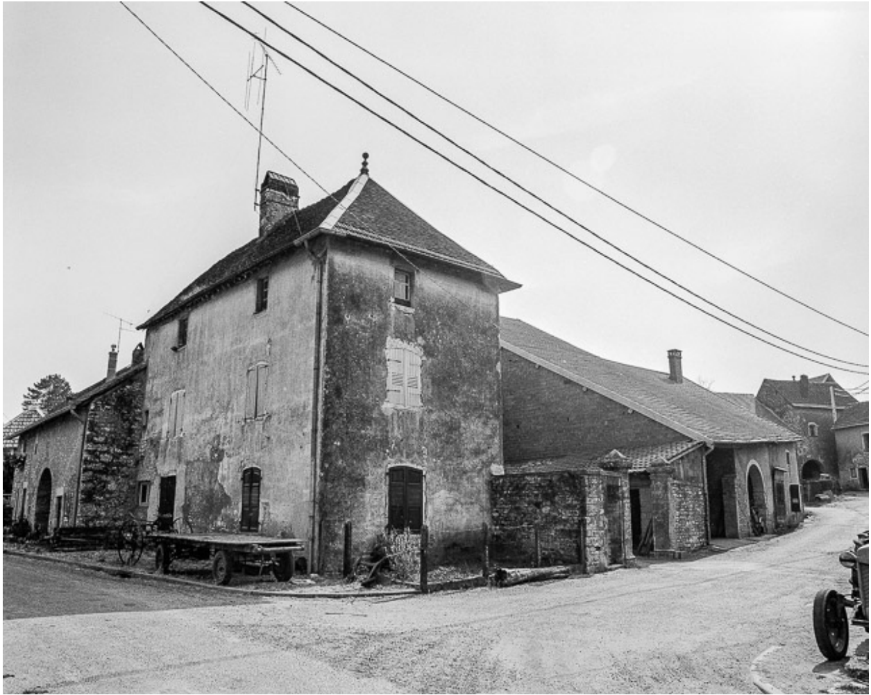
Maison située à l'angle de la rue d'Aval et rue de la Traverse.
