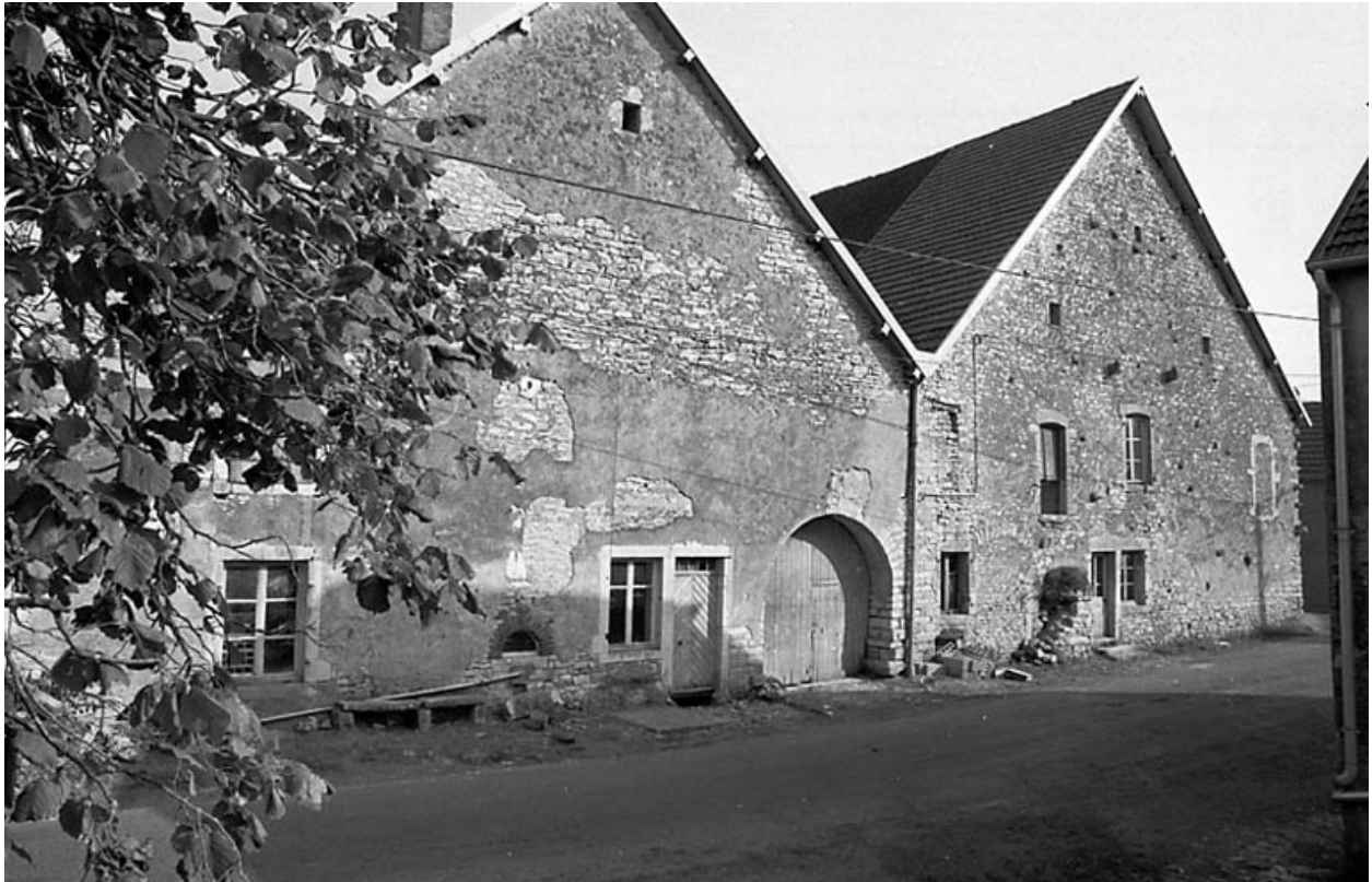
Ferme située à Morogne : façade antérieure.
