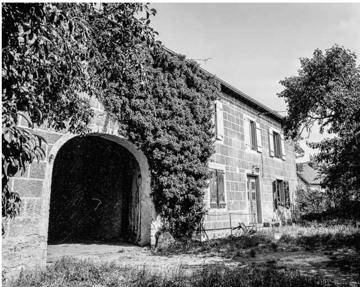
Ferme cadastrée 1973 AB 107, située rue de Montbozon : façade antérieure.
