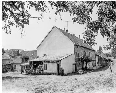
Maison cadastrée 1973 AB 11 située rue d'Aval à Chenevrey : façades postérieure et latérale droite. Phot. Dominique Humbert IVR43_19767000484X
