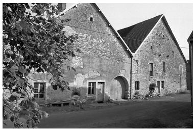
Ferme située à Morogne : façade antérieure. Phot. Bernard Lardière IVR43_19797000349Z
