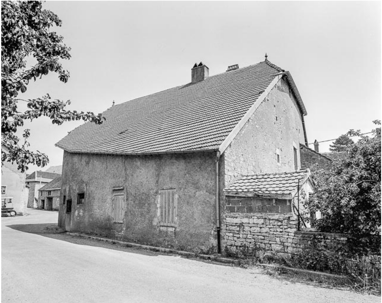
Ferme située entre la rue d'Amont et la rue de la Fontaine : Façade postérieure.
