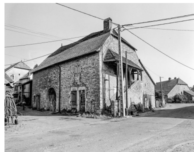
Ferme située rue d'Aval à Chevrevey : vue d'ensemble. Phot. Bernard Lardière IVR43_19767000441X
