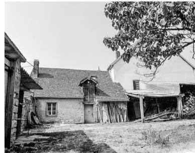
Maison cadastrée 1973 AB 11 située rue d'Aval à Chenevrey : détail de la façade latérale droite. Phot. Dominique Humbert IVR43_19767000485X
