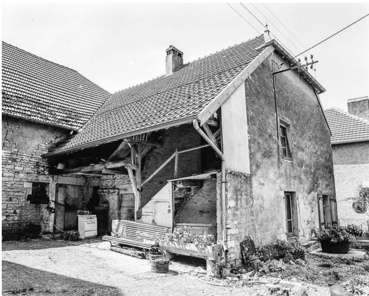
Maisons situées rue de Montbozon.: détail de l'aile droite du groupe de maisons.
