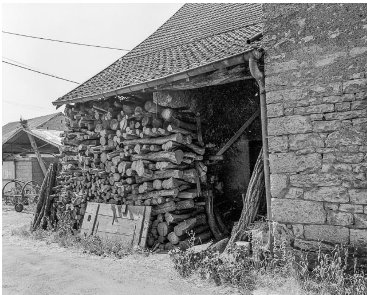
Maison située rue d'Aval à Chenevrey : façade latérale droite.
