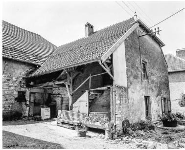
Maisons situées rue de Montbozon.: détail de l'aile droite du groupe de maisons. Phot. Dominique Humbert IVR43_19767000489X
