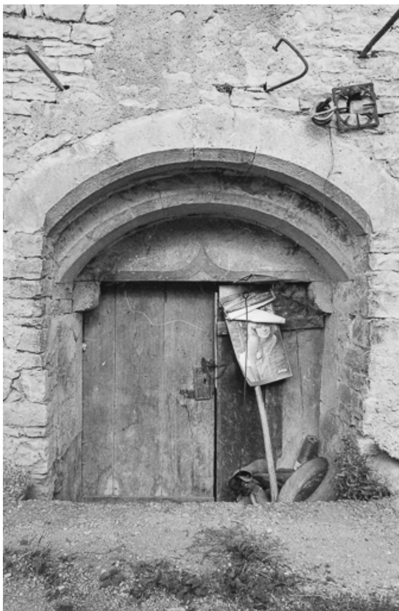
Ferme cadastrée 1973 AB 29 : entrée de cave.
