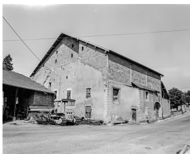
Maison située rue d'Amont à Chenevrey : façades antérieure et latérale gauche. Phot. Dominique Humbert IVR43_19767000454X
