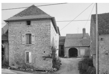
Ferme cadastrée 1973 AB 169. Phot. Bernard Lardière IVR43_19797000356Z
