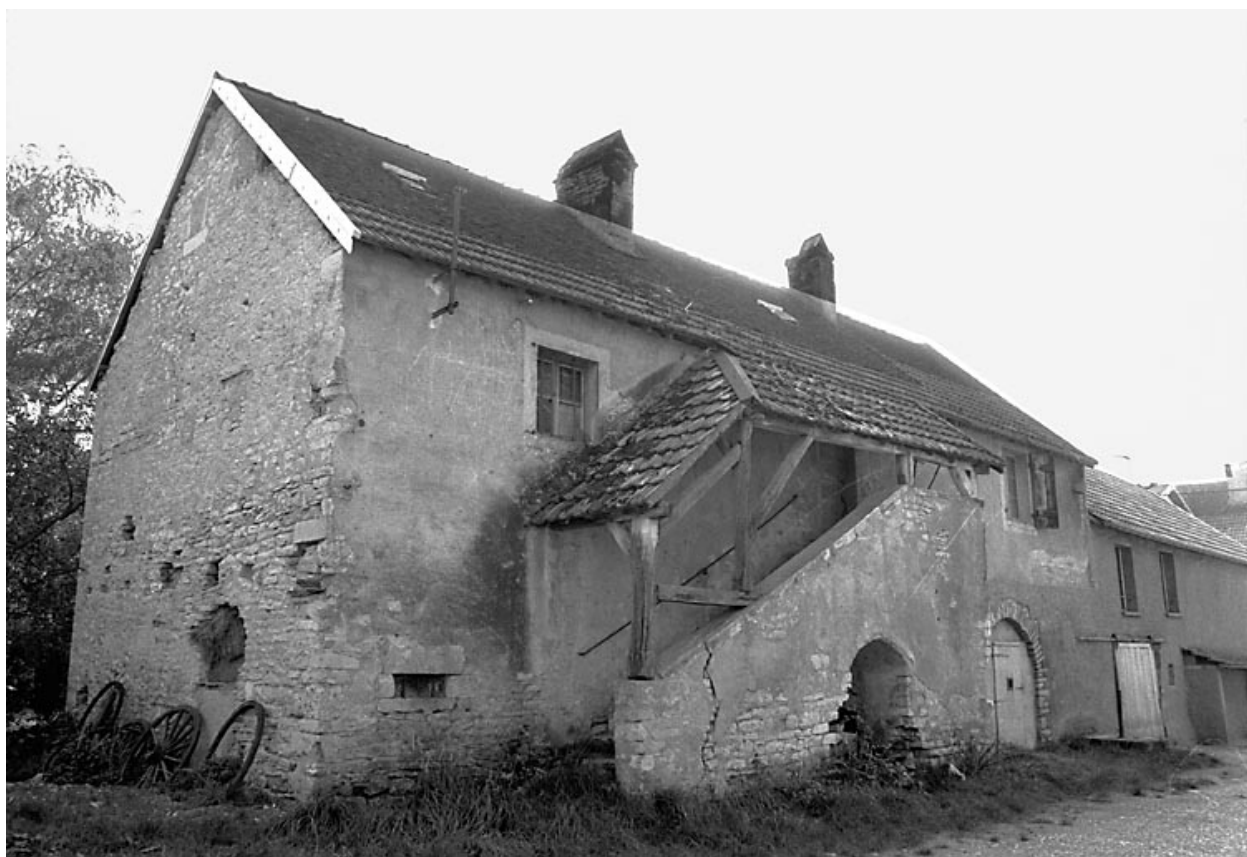
Maison située à Morogne : vue d'ensemble.
