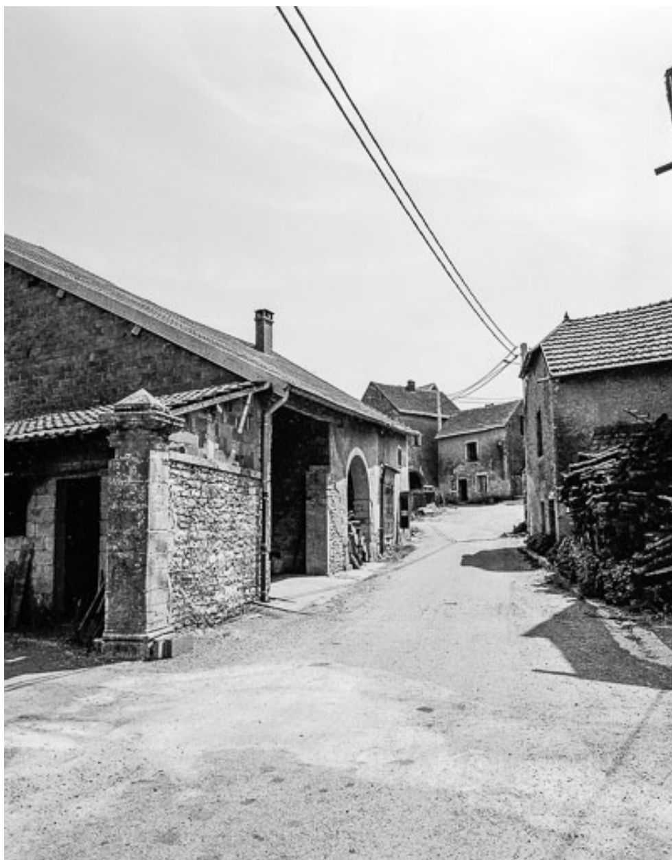
Maison située entre la rue de la Traverse et la ruelle des Escaliers : façade latérale gauche.
