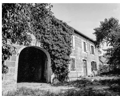
Ferme cadastrée 1973 AB 107, située rue de Montbozon : façade antérieure. Phot. Dominique Humbert IVR43_19767000497X
