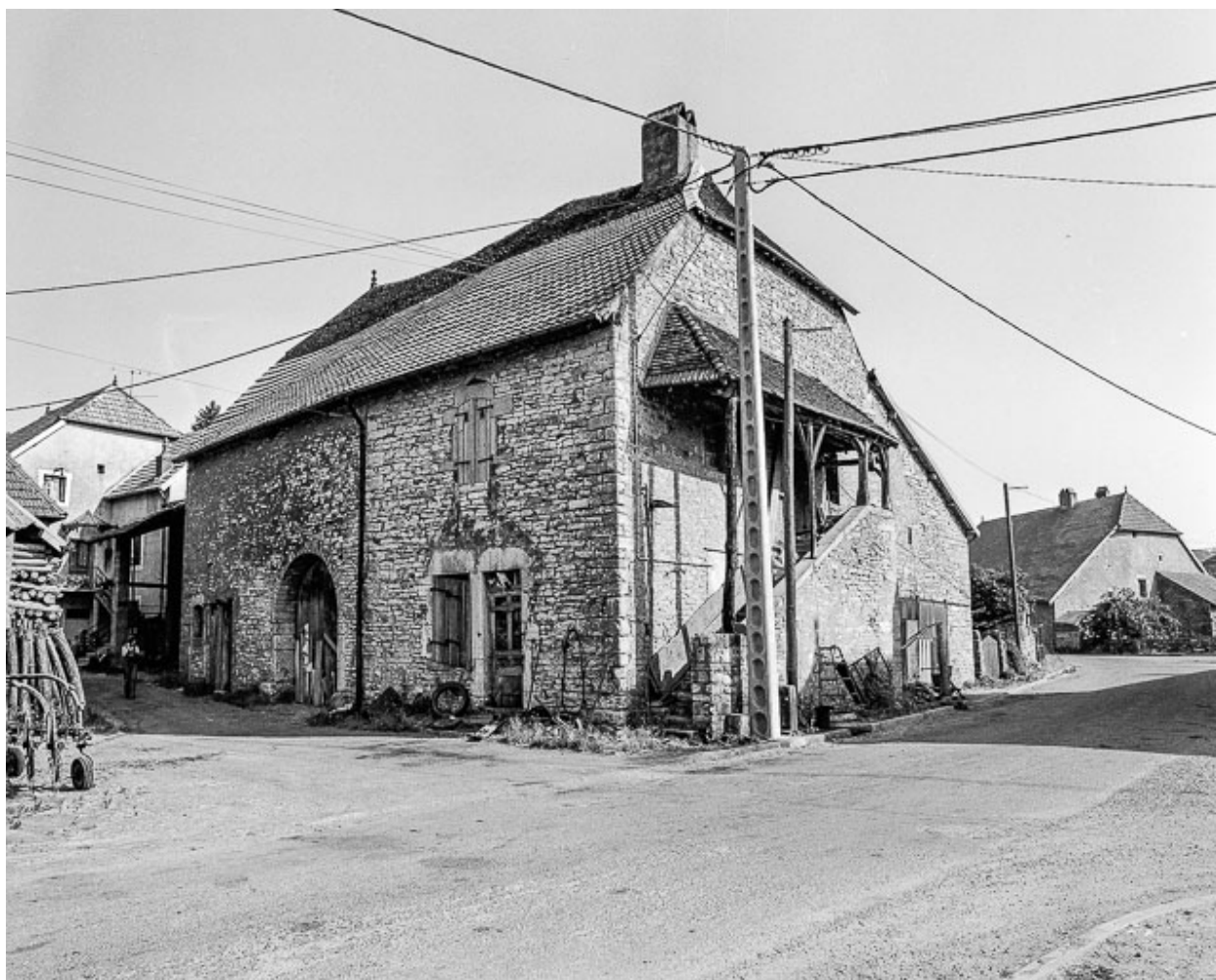
Ferme située rue d'Aval à Chenevrey : vue d'ensemble.
