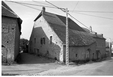
Ferme située rue de la Traverse à Chenevrey : vue d'ensemble. Phot. Bernard Lardière IVR43_19797000362Z
