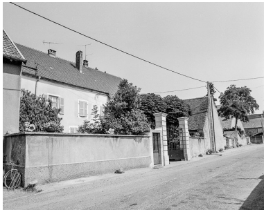
Maison cadastrée 1973 AB 11 située rue d'Aval à Chenevrey : façade antérieure et cour. Phot. Dominique Humbert IVR43_19767000483X
