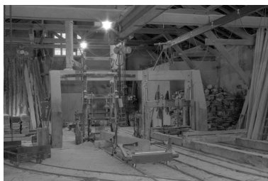
Châssis de scie. Phot. Laurent Poupard IVR43_19903900526Z
