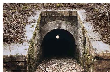
Aqueduc : tête amont (est). Phot. Yves Sancey IVR43_20053900892ZA
