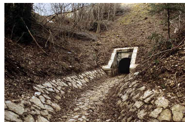
Aqueduc : tête aval et rigole (cadrage horizontal). Phot. Yves Sancey IVR43_20053900898ZA
