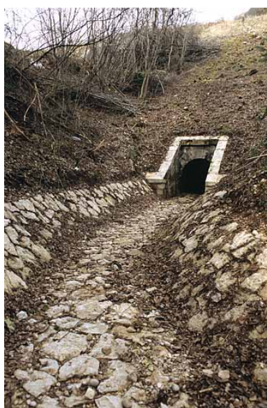
Aqueduc : tête aval (ouest) et rigole (cadrage vertical). Phot. Yves Sancey IVR43_20053900896ZA
