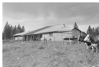
Façade antérieure avec accès à trois étables. Phot. Jérôme Mongreville IVR43_19963901363X
