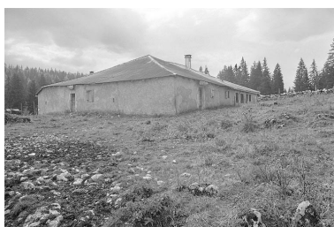
Angle nord du bâtiment. Phot. Jérôme Mongreville IVR43_19963901359X
