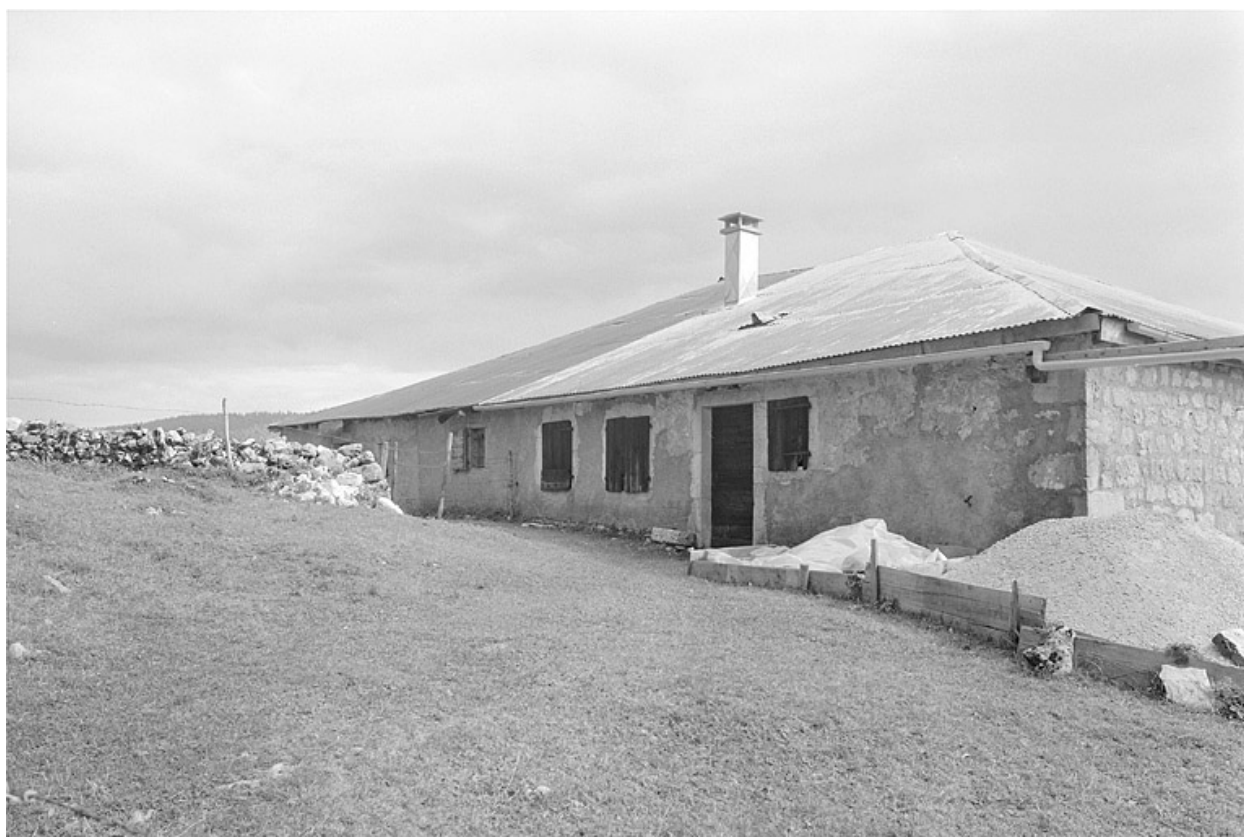
Façade postérieure, vue de trois quarts droit.
