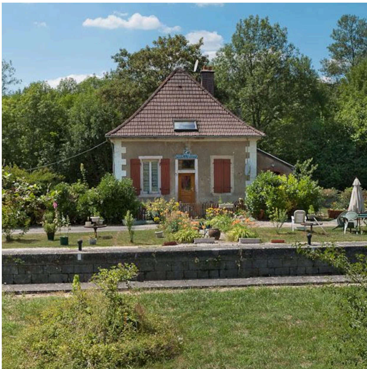
Vue de face de la maison éclusière.
