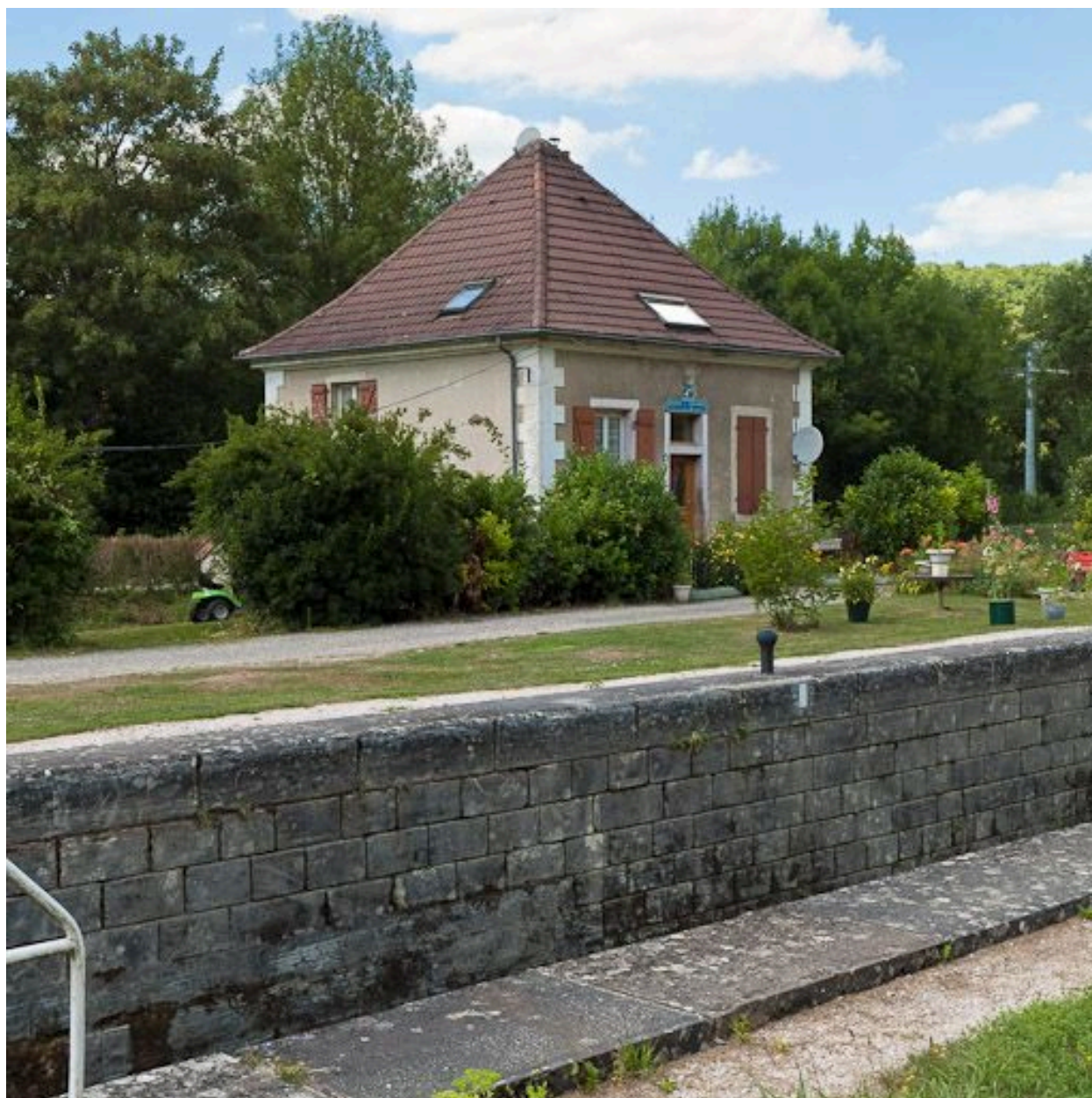
Vue d'ensemble du site d'écluse.
