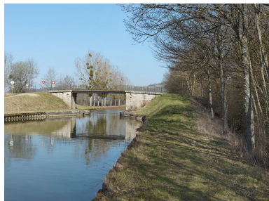
Le pont routier, vue d'ensemble. Phot. Thierry Kuntz IVR26_20122102721NUC4A
