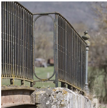
Le pont routier, détail des garde-corps. Phot. Thierry Kuntz IVR26_20122102725NUC2A
