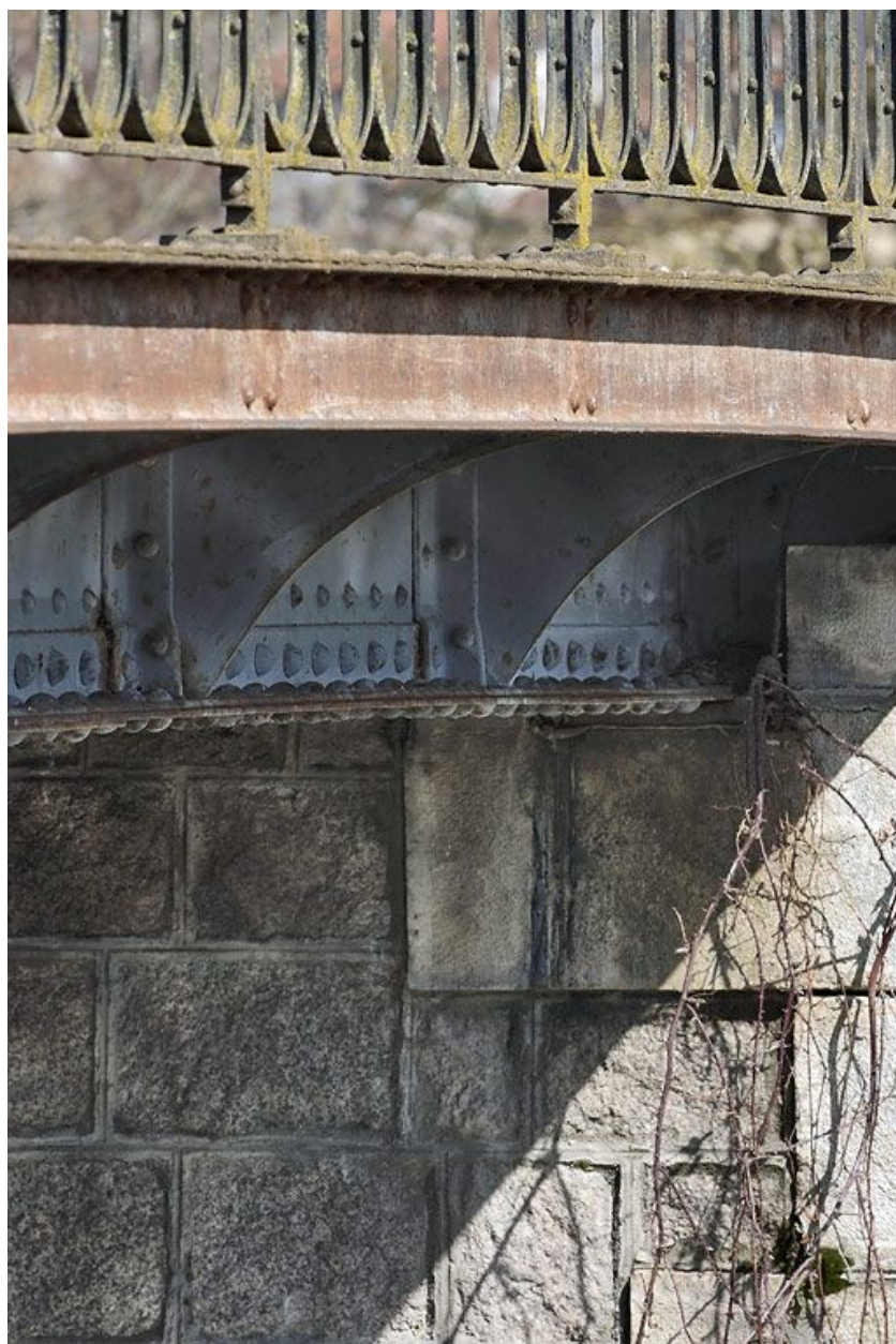
Le pont routier, détail du tablier métallique.
