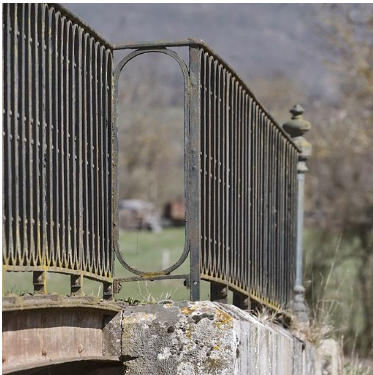
Le pont routier, détail des garde-corps.
