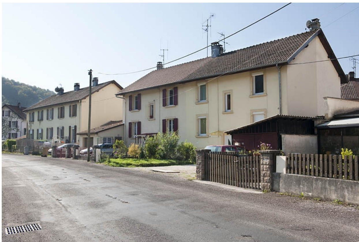
Habitations depuis la rue du canal.
