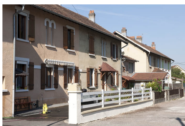
Façade antérieure d'habitations. Phot. Jérôme Mongreville IVR43_20112502449NUC4A
