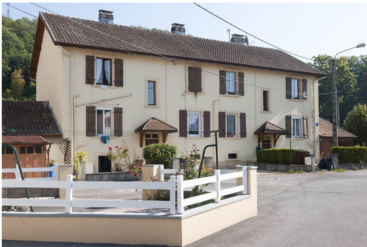
Façade antérieure d'une habitation.
