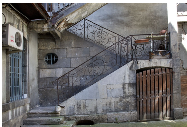
Escalier à cage ouverte : détail de la rampe en ferronnerie des premières volées. Phot. Yves Sancey IVR43_20112502011NUC2A
