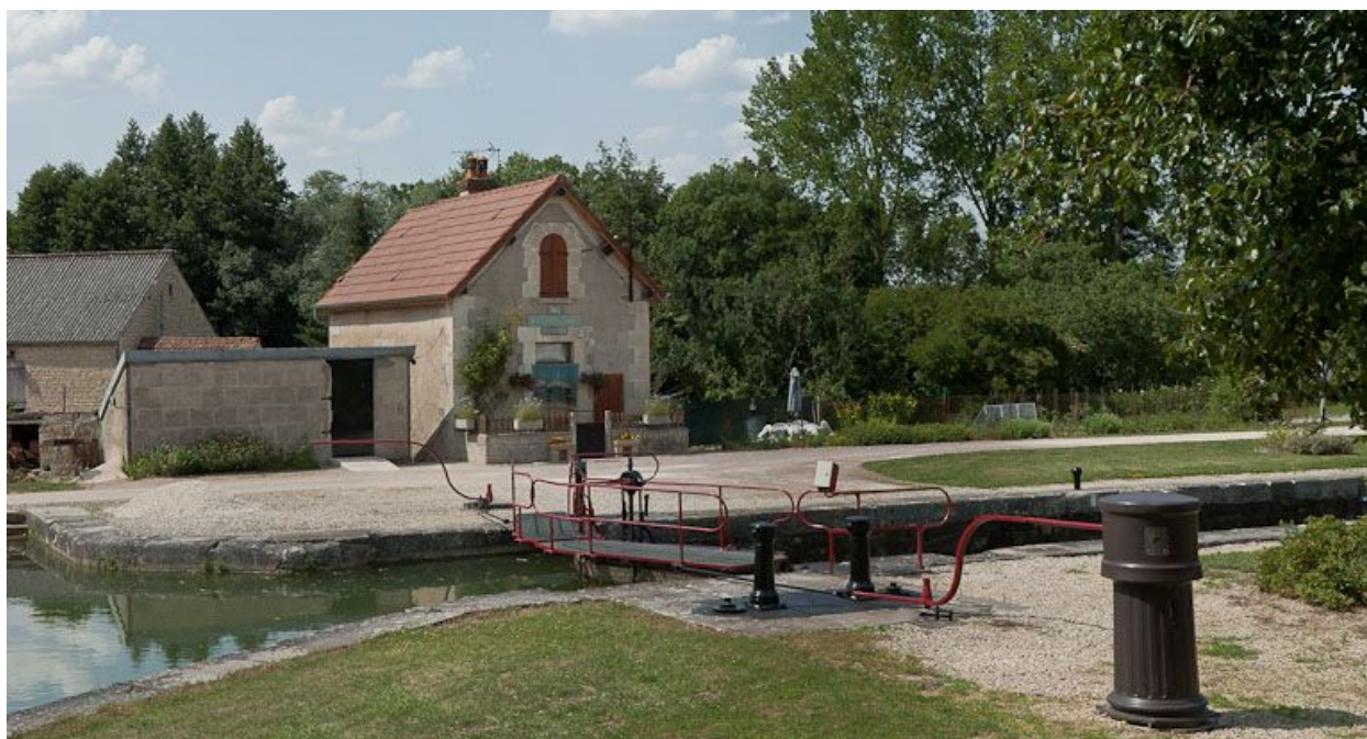
Vue d'ensemble du site d'écluse.
