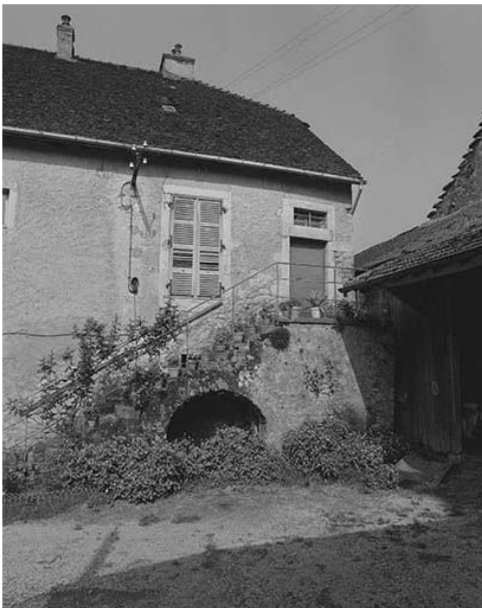
Façade antérieure : l'habitation.
