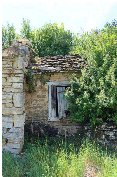
Vue du puits. Phot. Morgane Guillemain IVR26_20222101169NUC2A
