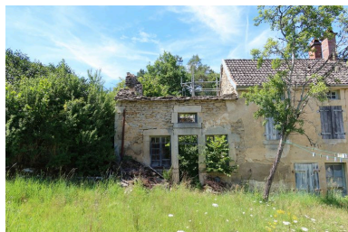
Vue d'ensemble depuis l'est. Phot. Morgane Guillemain IVR26_20222101141NUC2A
