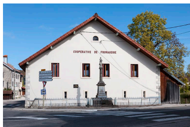
Façade antérieure. Phot. Jérôme Mongreville IVR43_20152501891NUC4A
