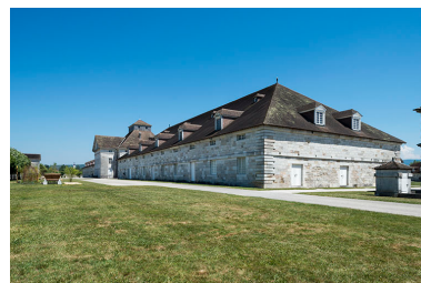
Façade postérieure des bernes.
