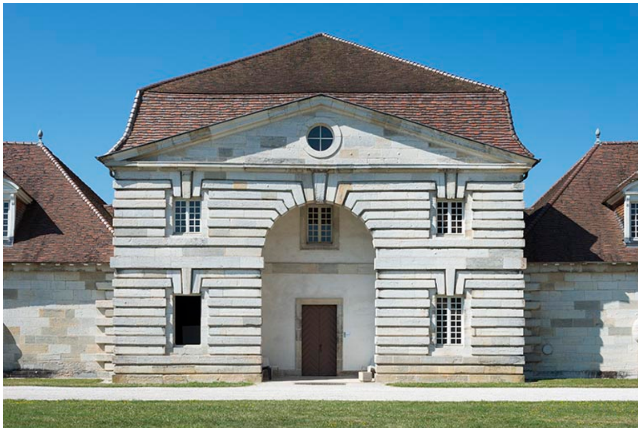
Logement des ouvriers ouest. Pavillon central.
