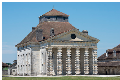
Maison du directeur. Vue rapprochée. Phot. Jérôme Mongreville IVR43_20152501415NUC4A
