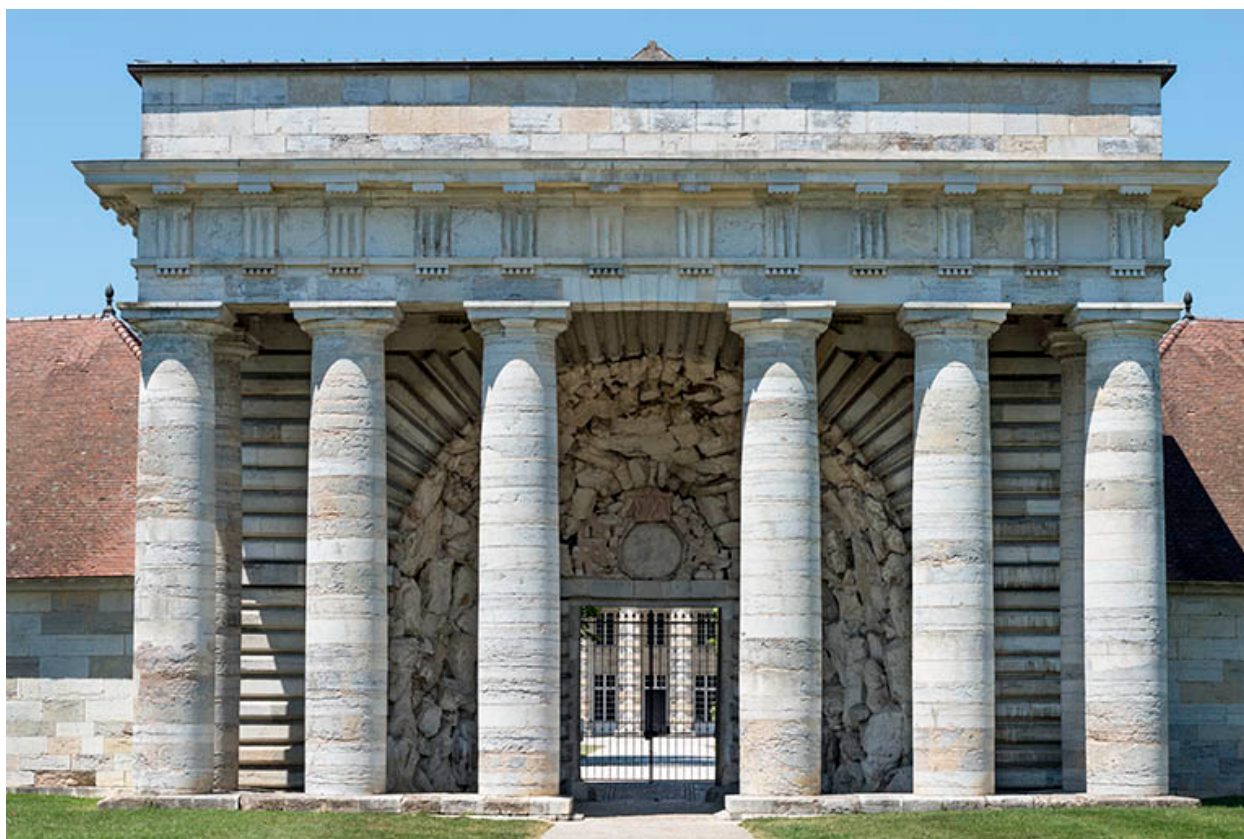
Vue axiale du portique d'entrée.
