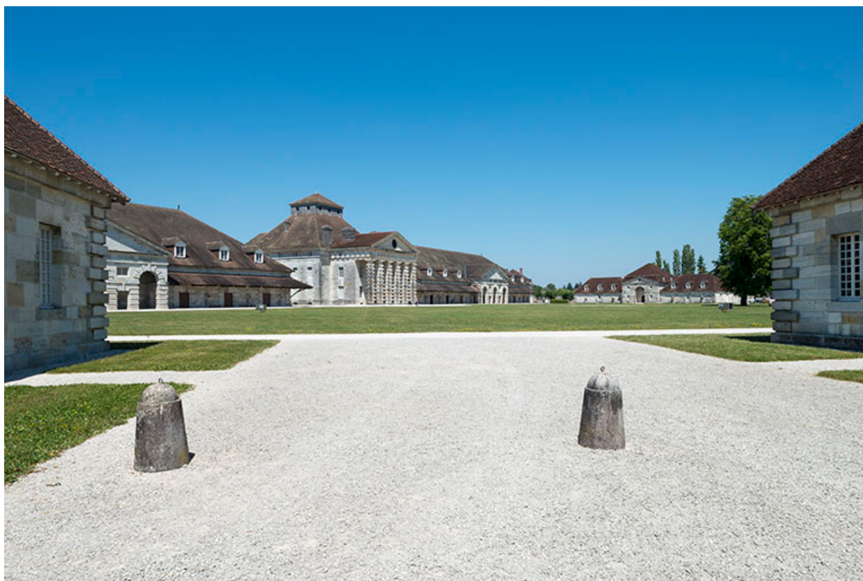
Vue d'ensemble depuis le mur sud.
