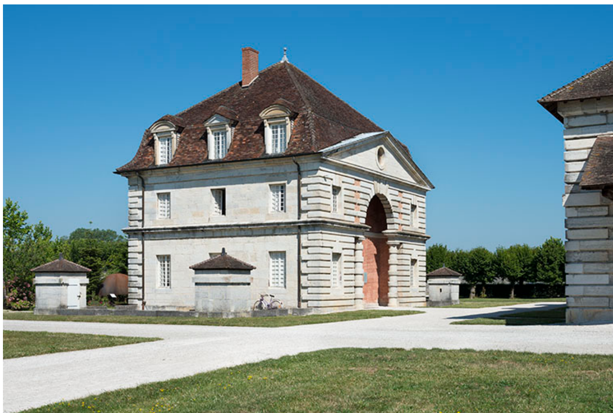
Maison des commis ouest. Vue depuis l'est.
