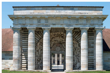
Vue axiale du portique d'entrée.
