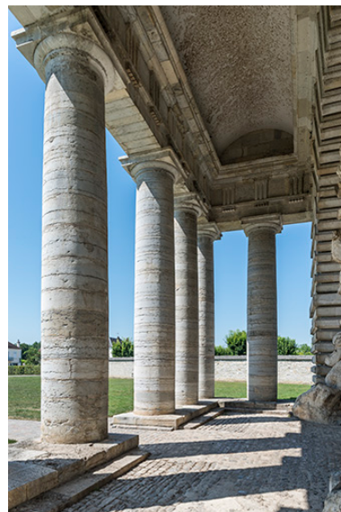
Détail du portique d'entrée.
