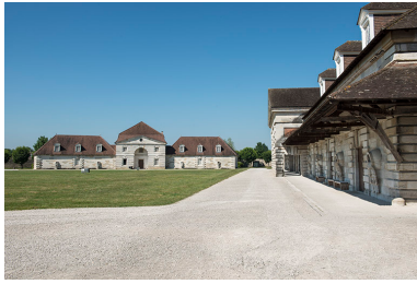
Logement des ouvriers et berne ouest. Phot. Jérôme Mongreville IVR43_20152501384NUC4A
