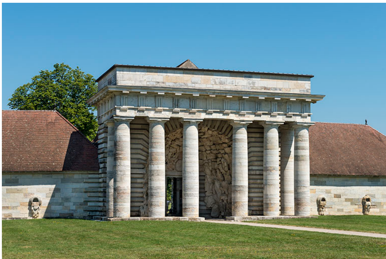
Portique du bâtiment d'entrée.
