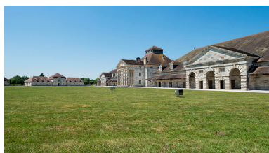
Vue d'ensemble depuis l'est de la cour.
