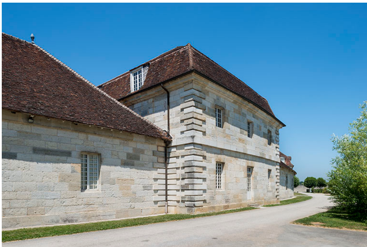
Façade postérieure du logements des ouvriers ouest.
