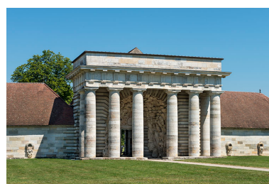
Portique du bâtiment d'entrée. Phot. Jérôme Mongreville
