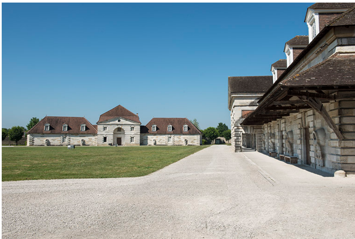
Logement des ouvriers et berne ouest.
