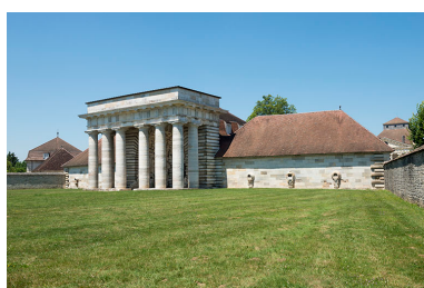
Bâtiment d'entrée. Vue de trois quarts droite.
