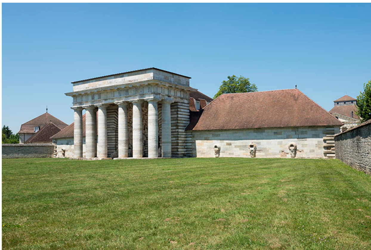
Bâtiment d'entrée. Vue de trois quarts droite.
