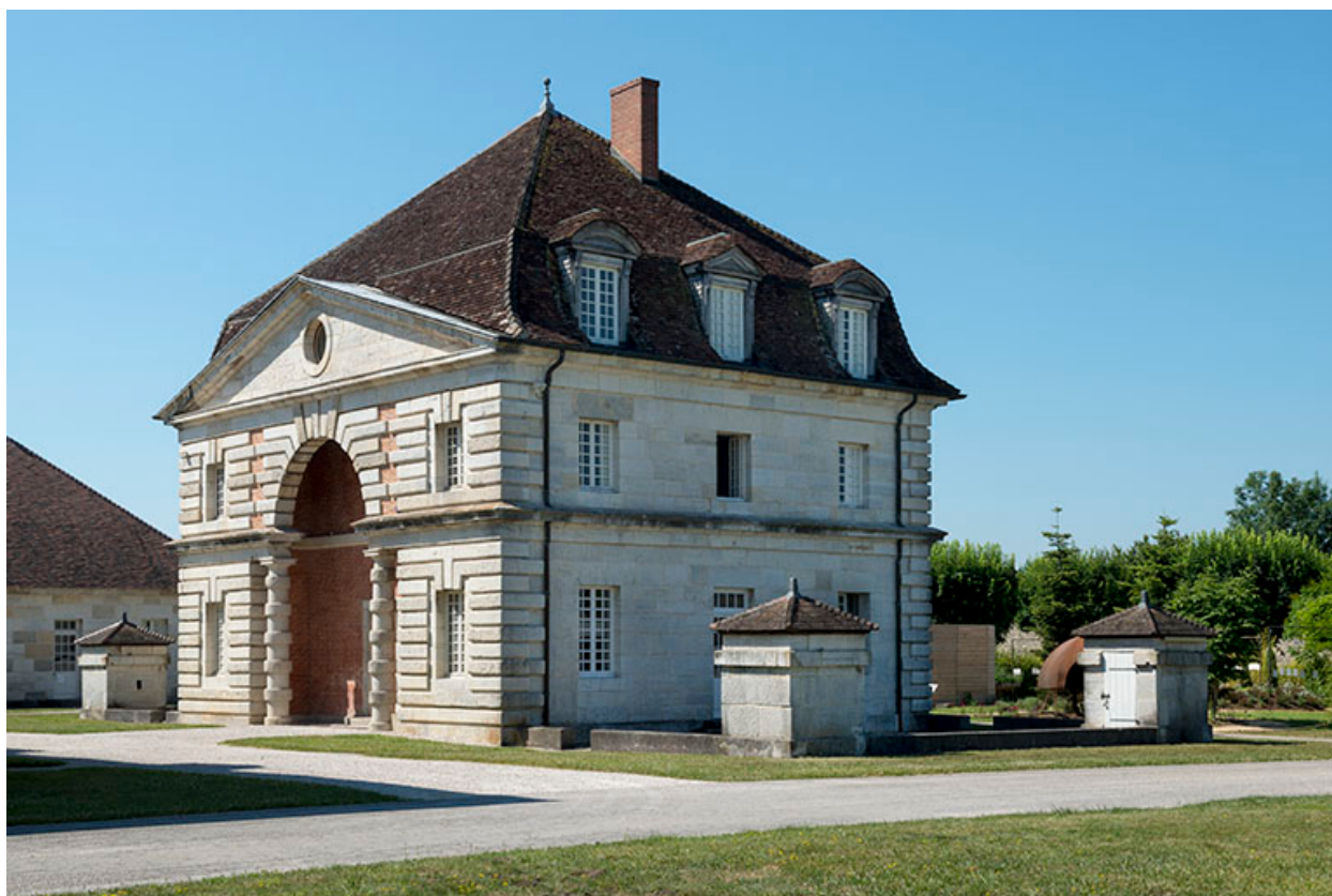
Maison des commis ouest.
