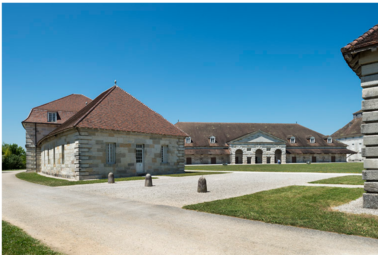
Logement d'ouvriers et berne ouest.
