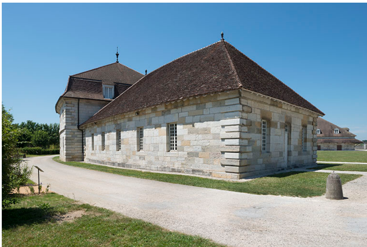
Tonnellerie vue de trois quarts arrière.
