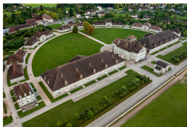
Vue aérienne depuis le sud. Phot. Jérôme Mongreville IVR43_20152500430NUC4A
