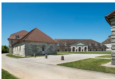
Logement d'ouvriers et berne ouest. Phot. Jérôme Mongreville IVR43_20152501424NUC4A
