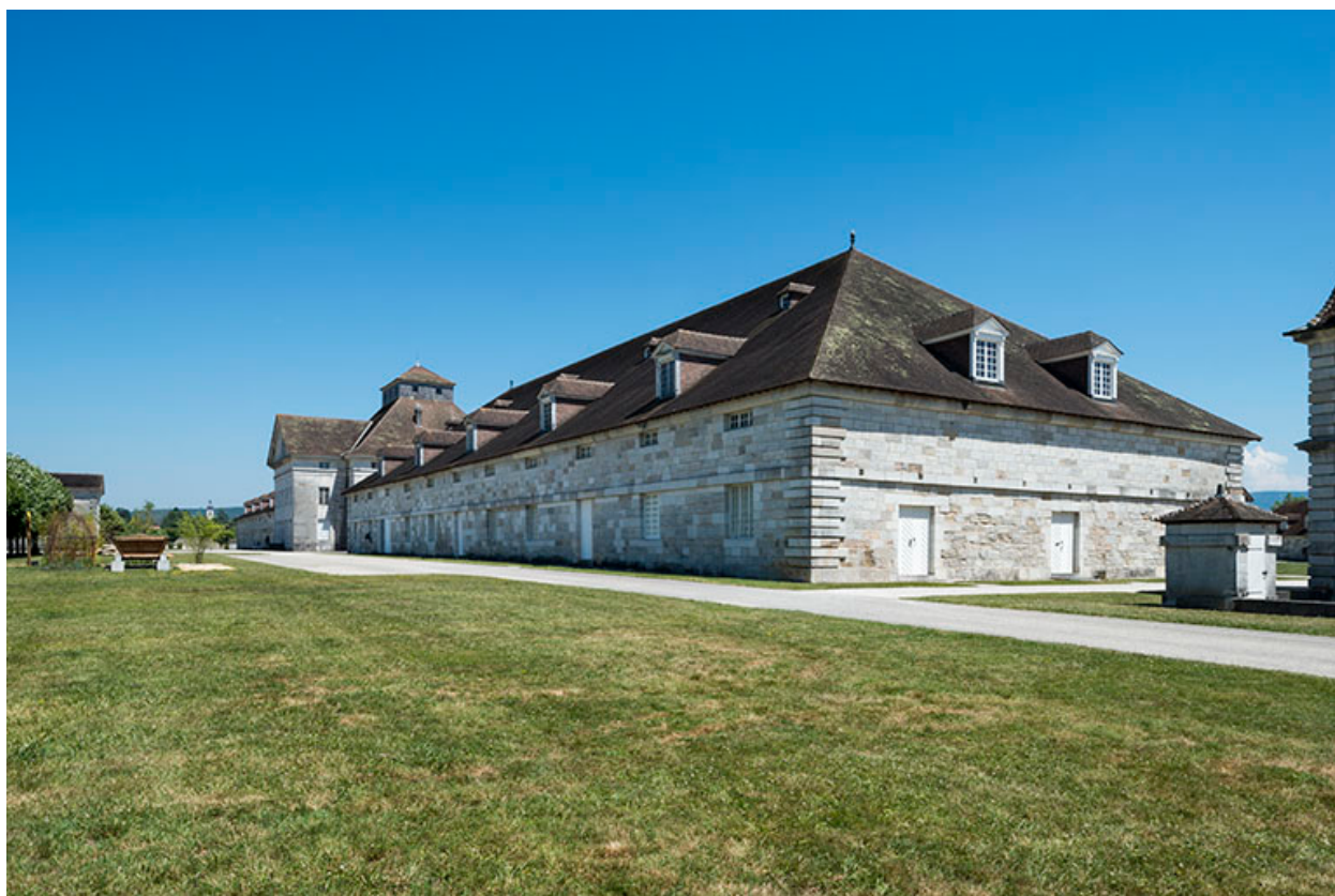
Façade postérieure des bernes.
