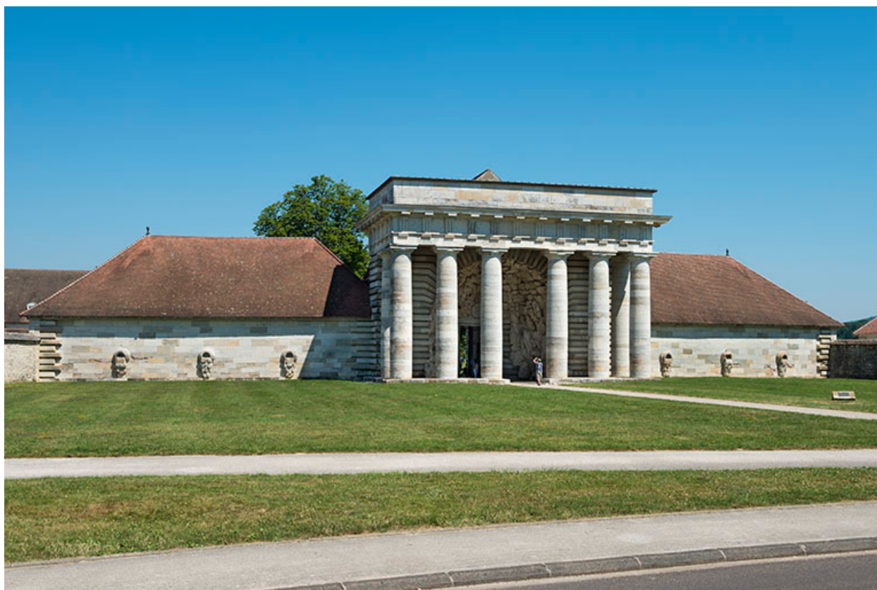
Bâtiment d'entrée, depuis le sud.
