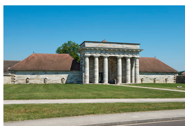
Bâtiment d'entrée, depuis le sud. Phot. Jérôme Mongreville
