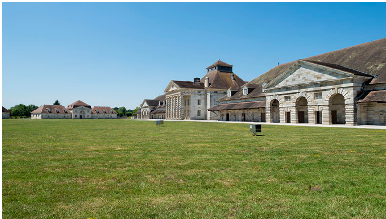
Vue d'ensemble depuis l'est de la cour.
