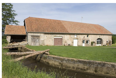
Bief d'amenée et façade antérieure. Phot. Jérôme Mongreville IVR43_20077000149NUCA
