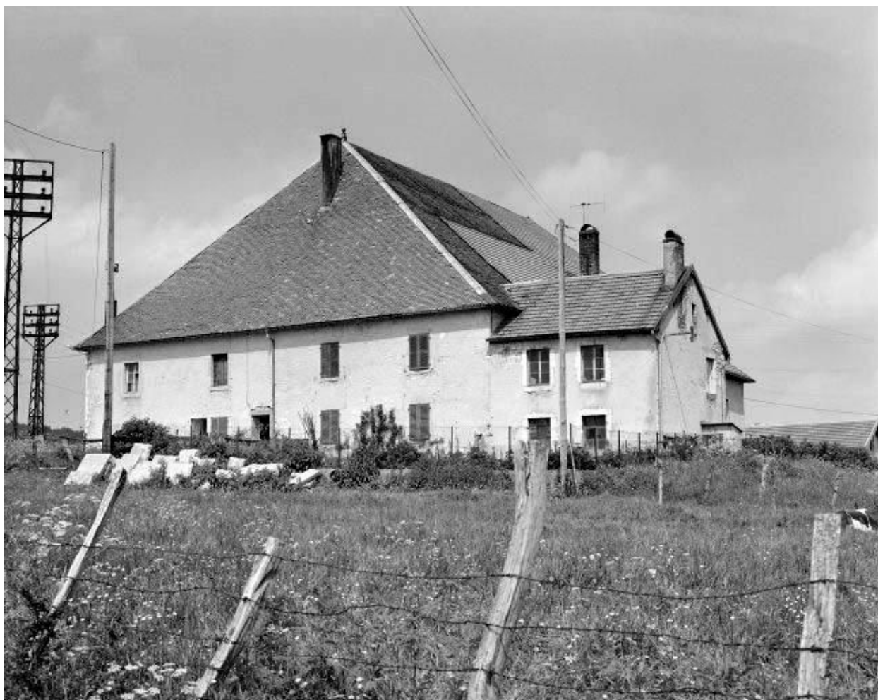
Ferme située rue Principale : vue d'ensemble.
