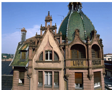
Ensemble des parties hautes, côté rue Cuvier. Phot. Jérôme Mongreville IVR43_19872500629XA
