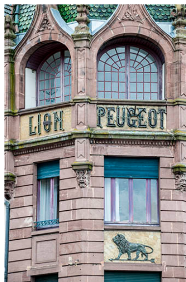
Elévation de la tour. Phot. Jérôme Mongreville IVR43_20132502797NUC4A
