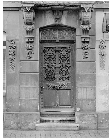
Porte d'entrée. Phot. Jérôme Mongreville IVR43_19872500366X
