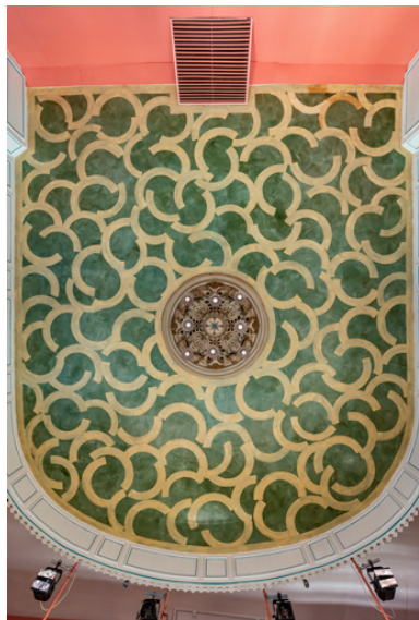
Vue d'ensemble du plafond. Phot. Pierre-Marie Barbe-Richaud IVR26_20238900337NUC4A
