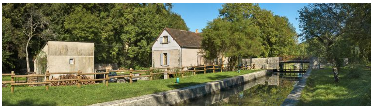
Vue d'ensemble du site écluse.
