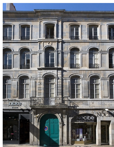
Vue d'ensemble de la façade sur rue, de face. Phot. Yves Sancey IVR43_20082500570NUC2A
