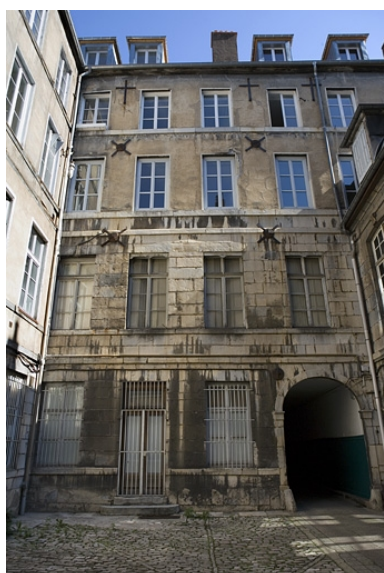
Vue d'ensemble de la façade postérieure du logis sur rue, de face. Phot. Yves Sancey IVR43_20082500587NUC2A
