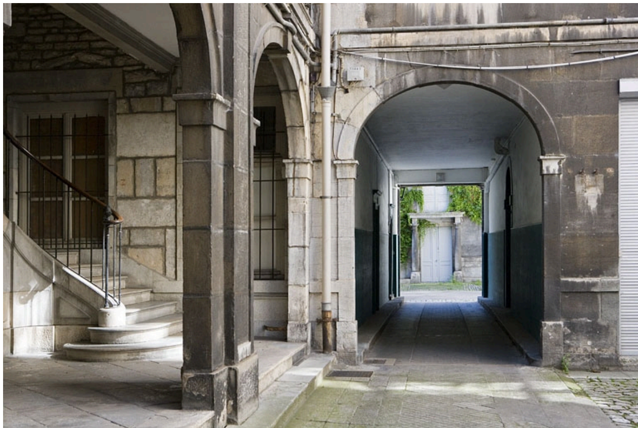
Détail de l'entrée du passage cocher au rez-de-chaussée du logis secondaire.
