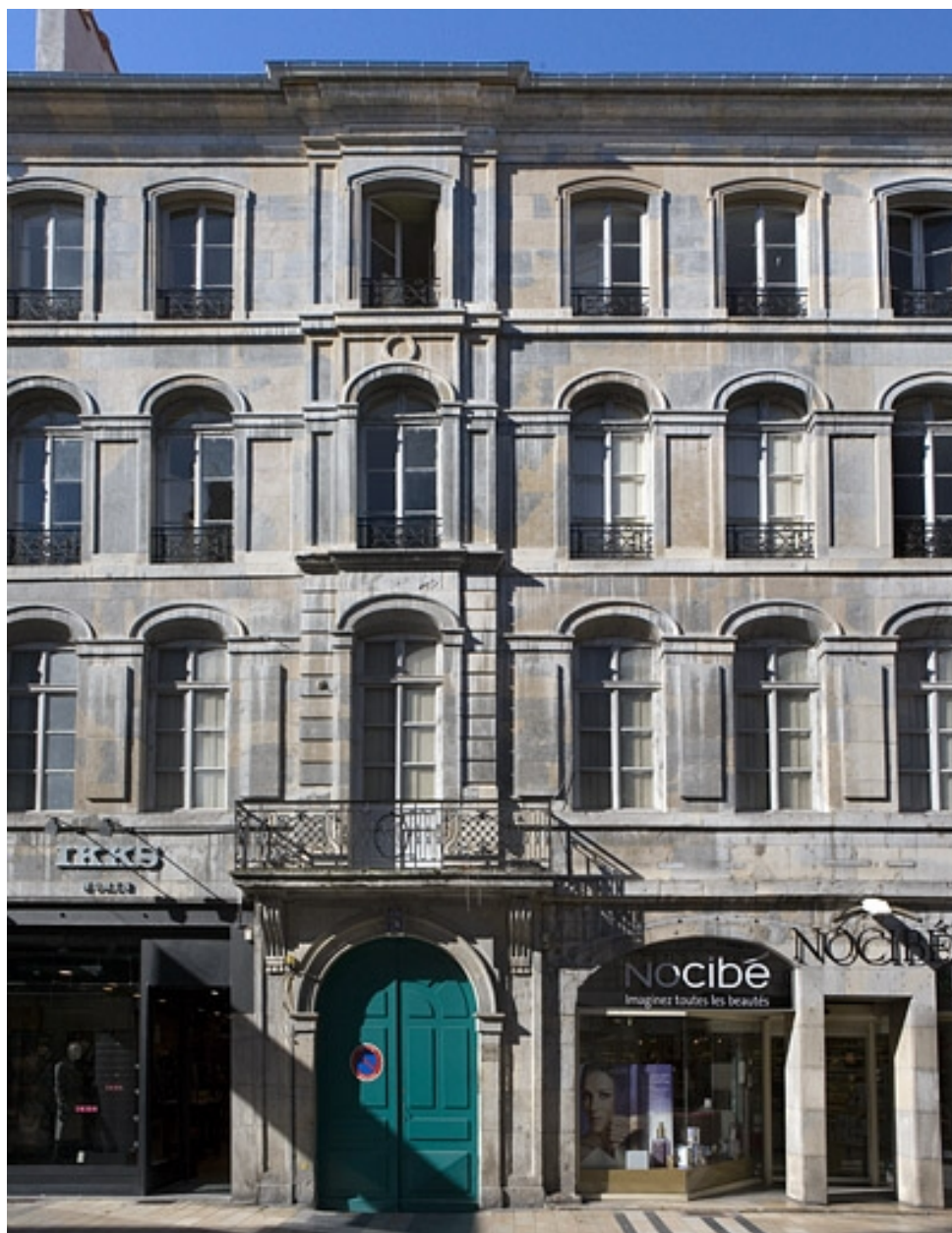
Vue d'ensemble de la façade sur rue, de face.
