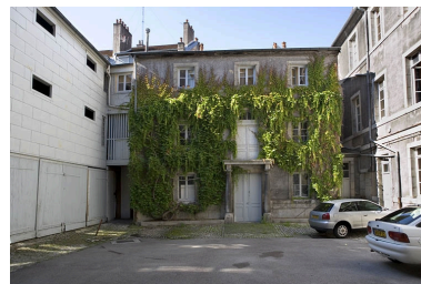
Vue d'ensemble du logis situé au fond de la deuxième cour. Phot. Yves Sancey IVR43_20082500577NUC2A
