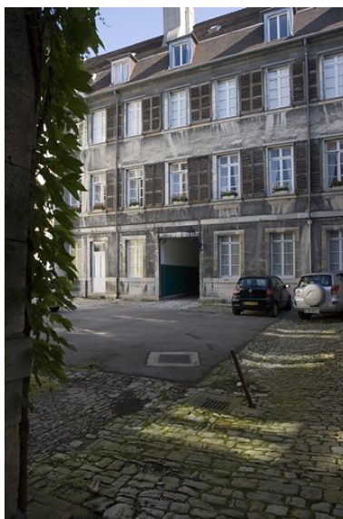
Deuxième cour : vue d'ensemble de l'aile droite, de trois quarts droit. Phot. Yves Sancey IVR43_20082500578NUC2A
