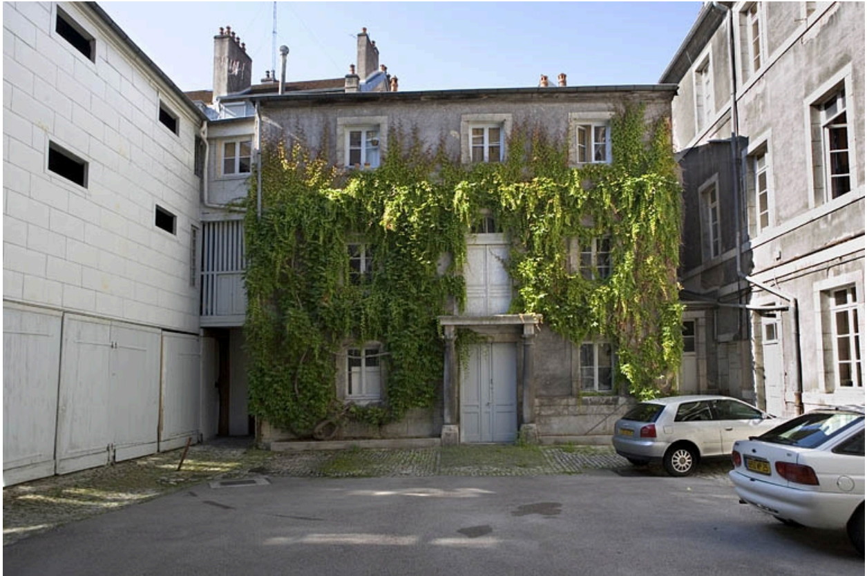
Vue d'ensemble du logis situé au fond de la deuxième cour.
