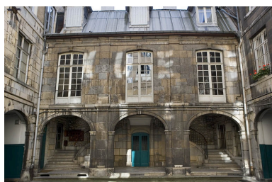
Première cour : vue d'ensemble de l'aile gauche, de face. Phot. Yves Sancey IVR43_20082500575NUC2A
