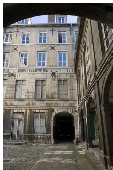
Vue d'ensemble de la façade postérieure du logis sur rue depuis le fond de la première cour. Phot. Yves Sancey IVR43_20082500582NUC2A
