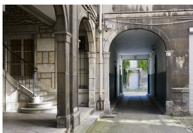
Détail de l'entrée du passage cocher au rez-de-chaussée du logis secondaire. Phot. Yves Sancey IVR43_20082500572NUC2A
