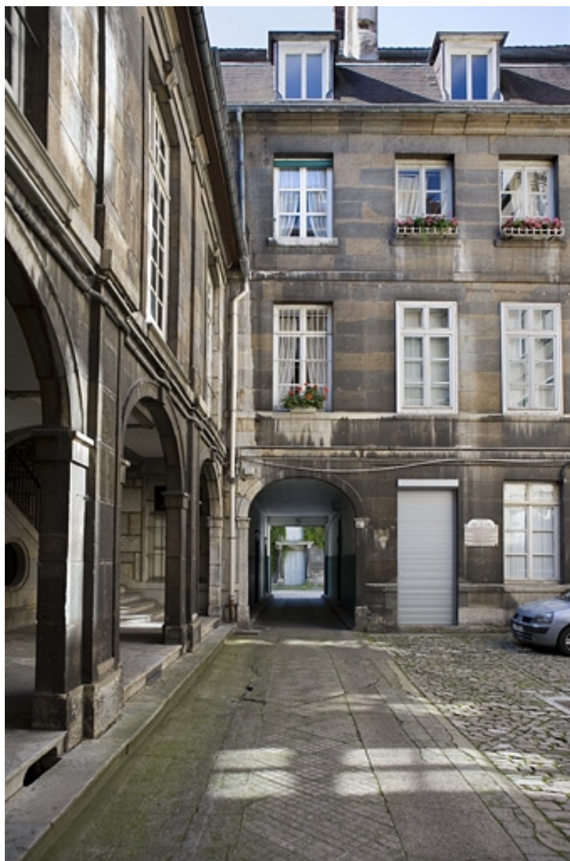
Détail de l'aile droite et de la façade antérieure du logis secondaire depuis l'entrée de la première cour.
