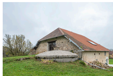
Vue depuis l'ouest. Au premier plan, la citerne semi-enterrée. Phot. Jérôme Mongreville IVR43_20243901066NUC4A
