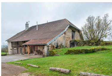
Vue de trois quarts droite. Phot. Jérôme Mongreville IVR43_20243901068NUC4A
