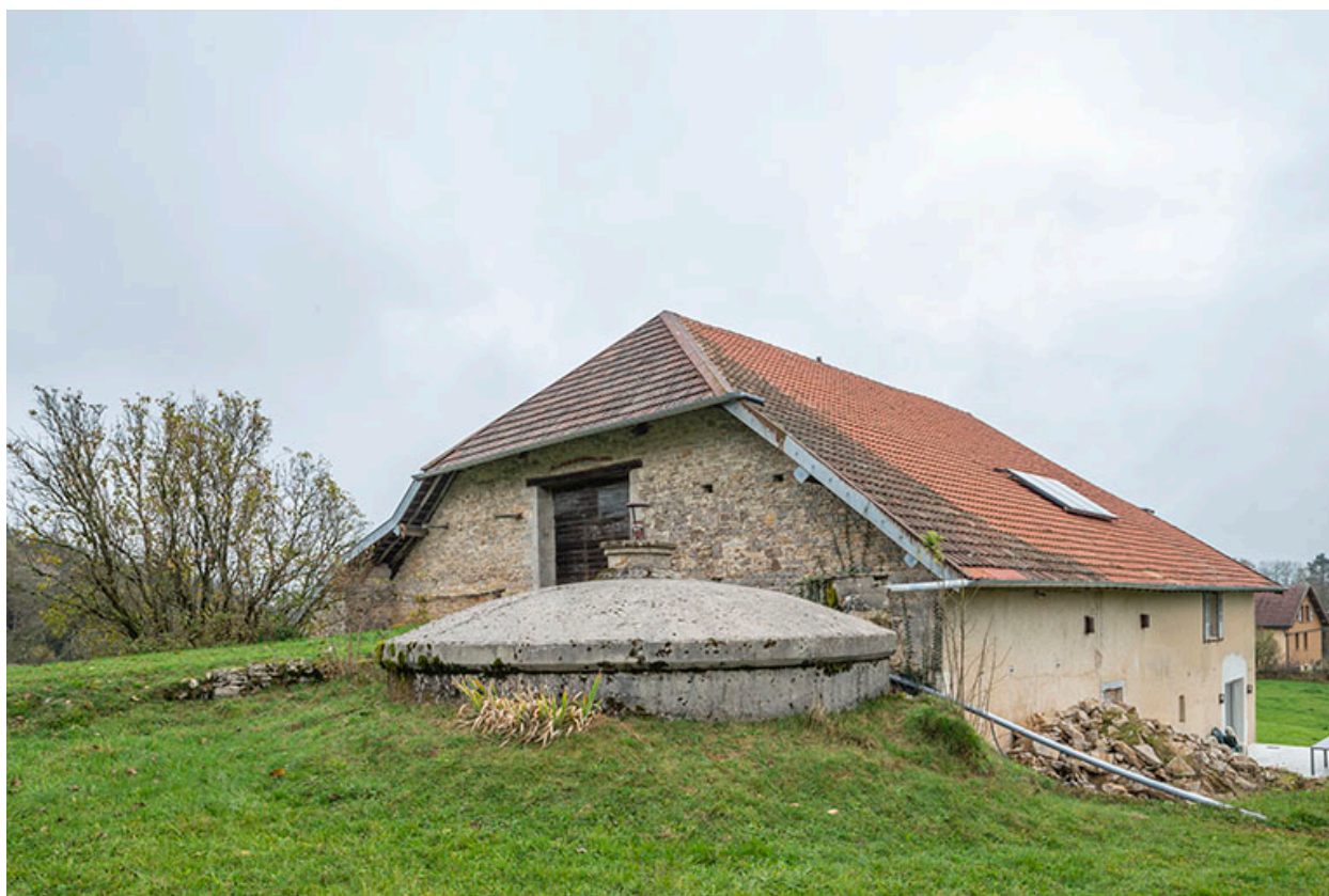
Vue depuis l'ouest. Au premier plan, la citerne semi-enterrée.
