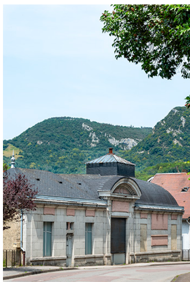
Vue de trois quarts gauche (cadrage vertical). Phot. Jérôme Mongreville IVR43_20233900676NUC4A
