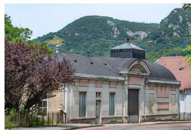
Vue éloignée, depuis le sud-est. Phot. Jérôme Mongreville IVR43_20233900677NUC4A
