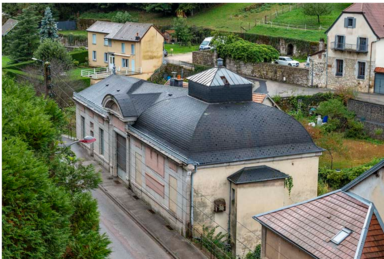
Vue plongeante depuis le nord-est.
