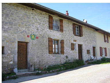
Ferme située au lieu-dit les Vuillomets. Phot. Marie-Pierre Reynet IVR43_20083900317NUC1A
