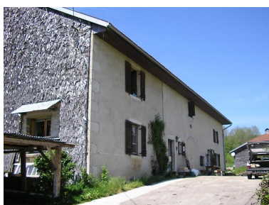
Ferme située au lieu-dit les Vuillomets. Phot. Marie-Pierre Reynet IVR43_20083900312NUC1A
