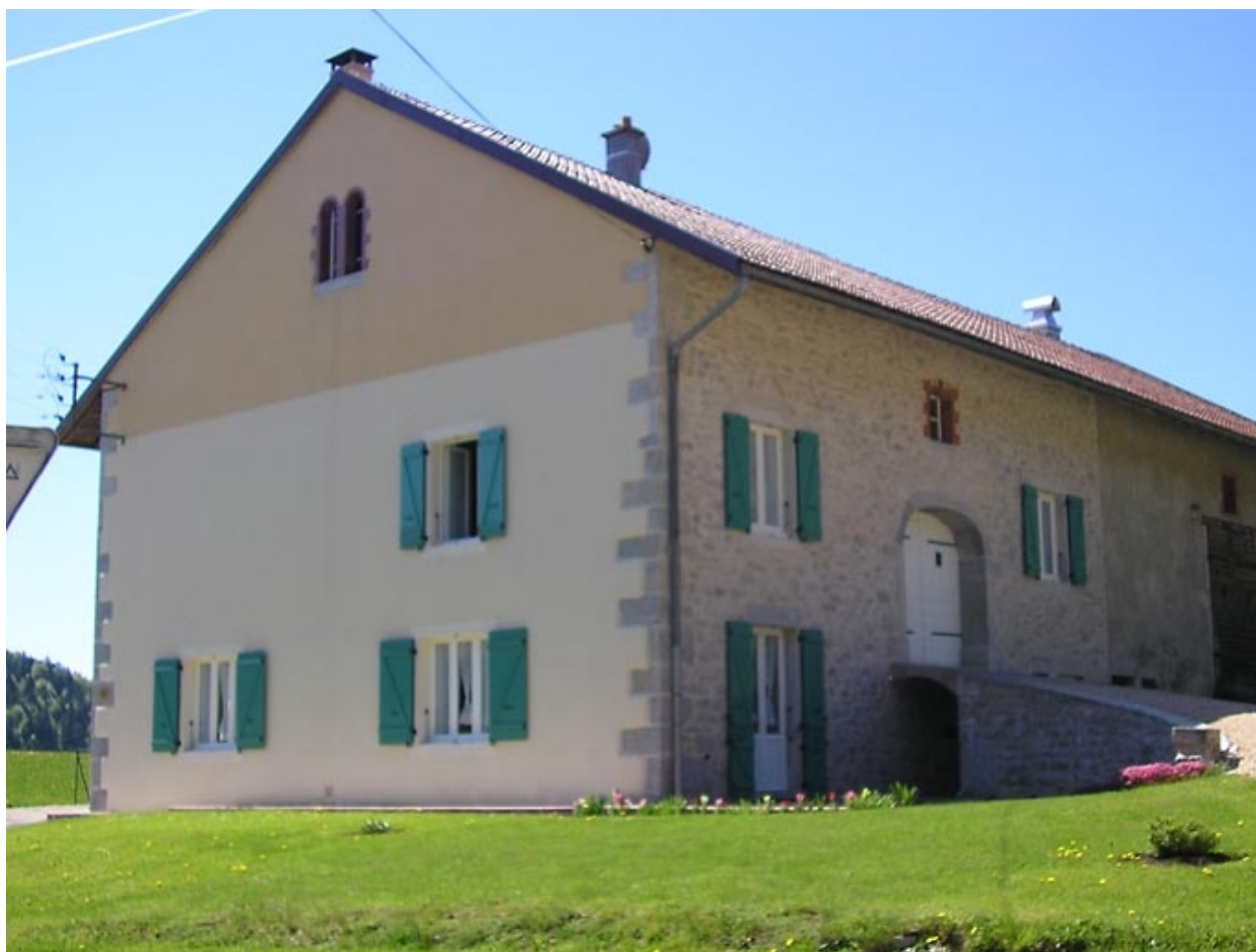
Ferme située au lieu-dit les Fans.
