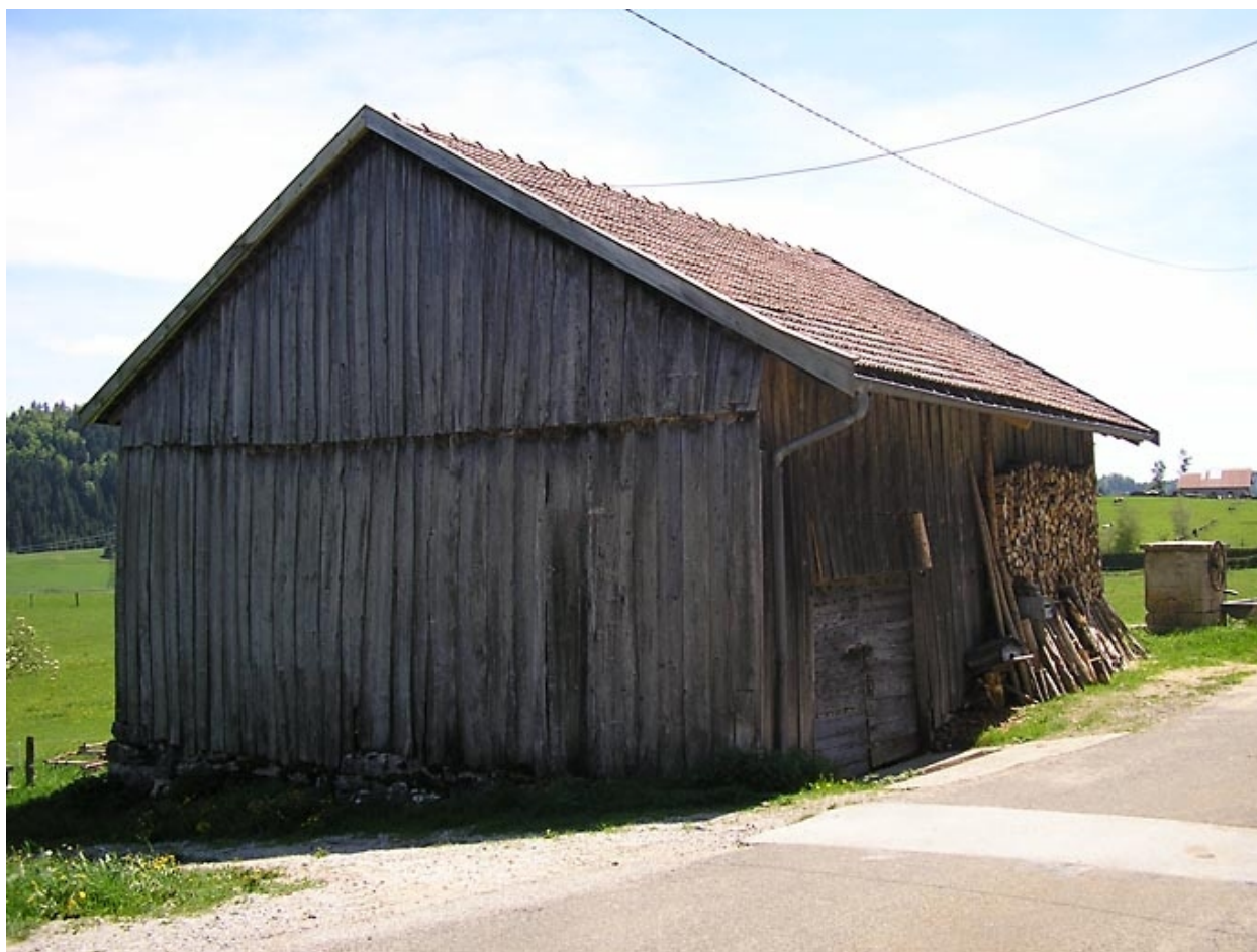
Remise agricole située au lieu-dit les Vuillemets.
