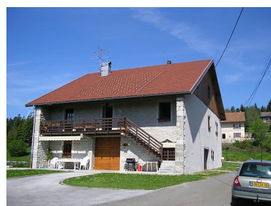
Ferme située 18 les Janiers. Phot. Marie-Pierre Reynet IVR43_20083900305NUC1A
