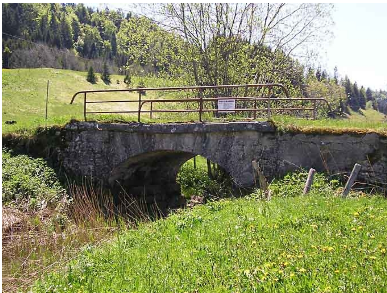
Pont située au lieu-dit les Fans.
