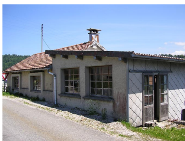
Atelier de menuiserie situé au lieu-dit Prénovel de Bise. Phot. Marie-Pierre Reynet IVR43_20083900339NUC1A
