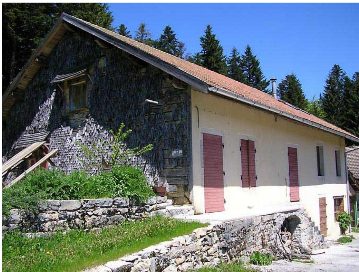
Ferme située au lieu-dit les Fans.
