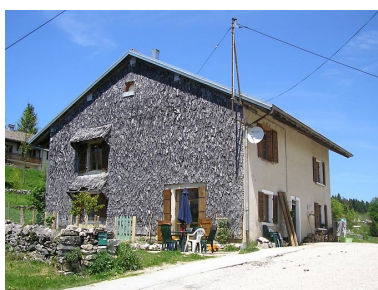
Ferme située 8 les Vignettes. Phot. Marie-Pierre Reynet IVR43_20083900309NUC1A
