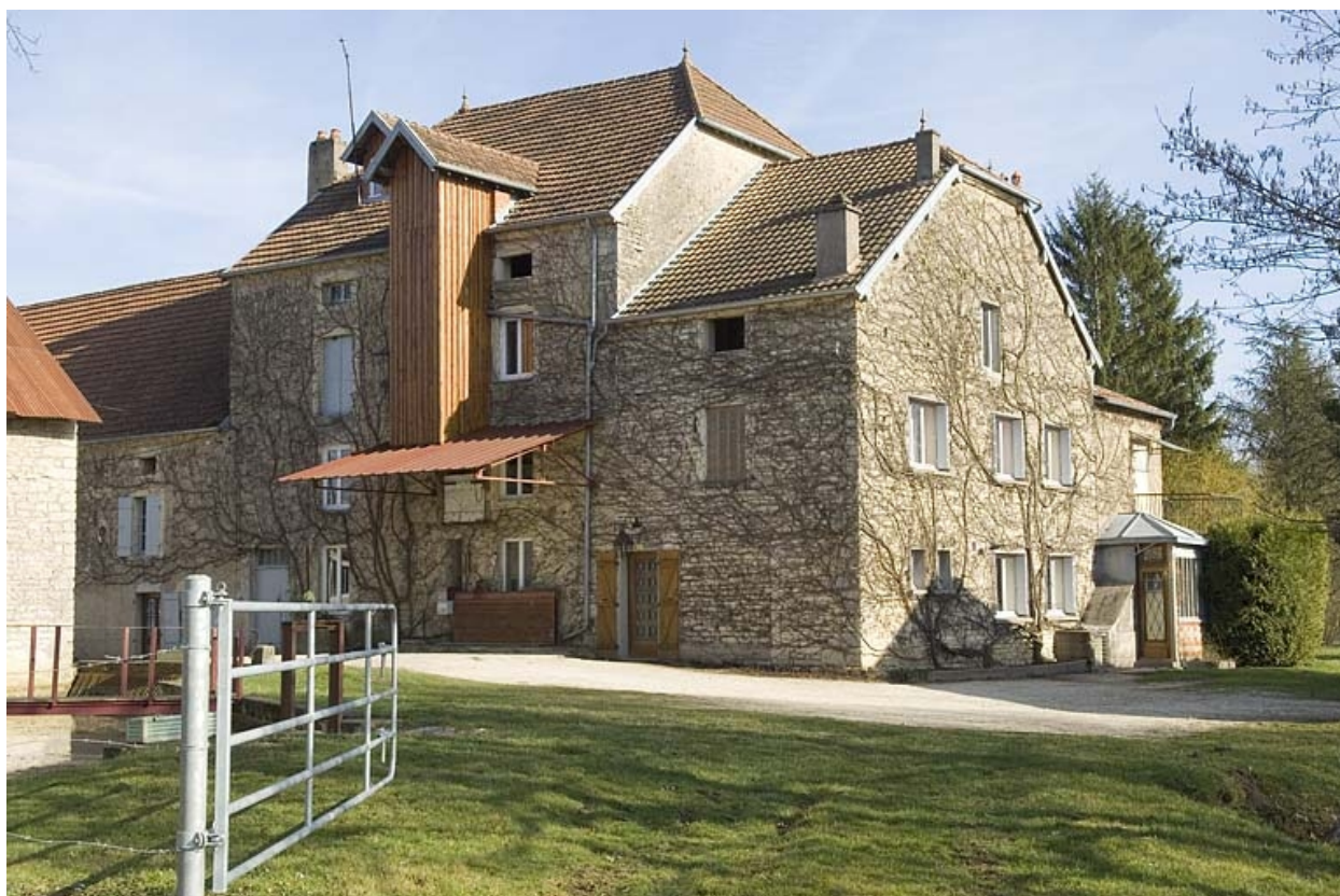
Vue rapprochée depuis l'ouest.
