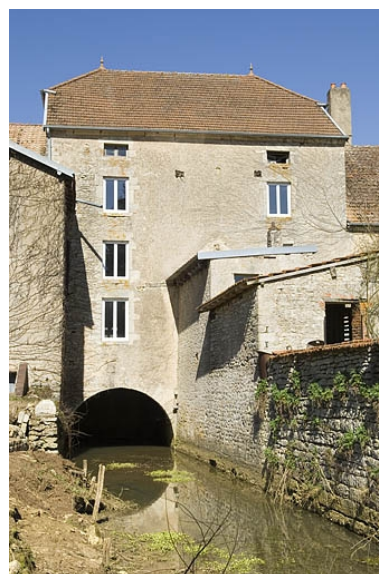
Façade postérieure depuis le bief d'aval. Phot. Jérôme Mongreville IVR43_20097000155NUC2A
