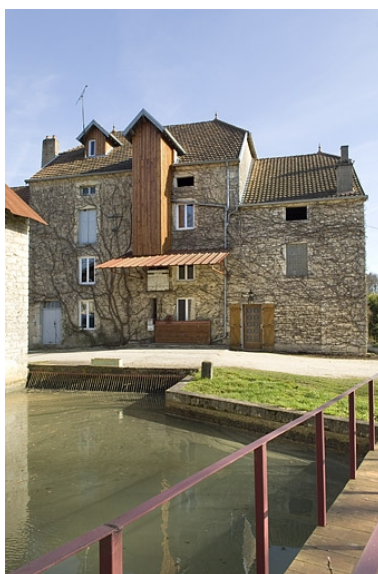
Façade antérieure. Phot. Jérôme Mongreville IVR43_20097000150NUC2A
