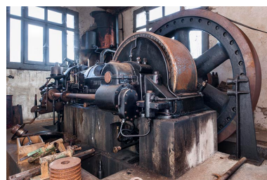
Moteur diesel Duvant. Phot. Jérôme Mongreville IVR43_20152502398NUC4A
