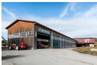
Extension de l'atelier de sciage. Phot. Jérôme Mongreville IVR43_20152502393NUC4A
