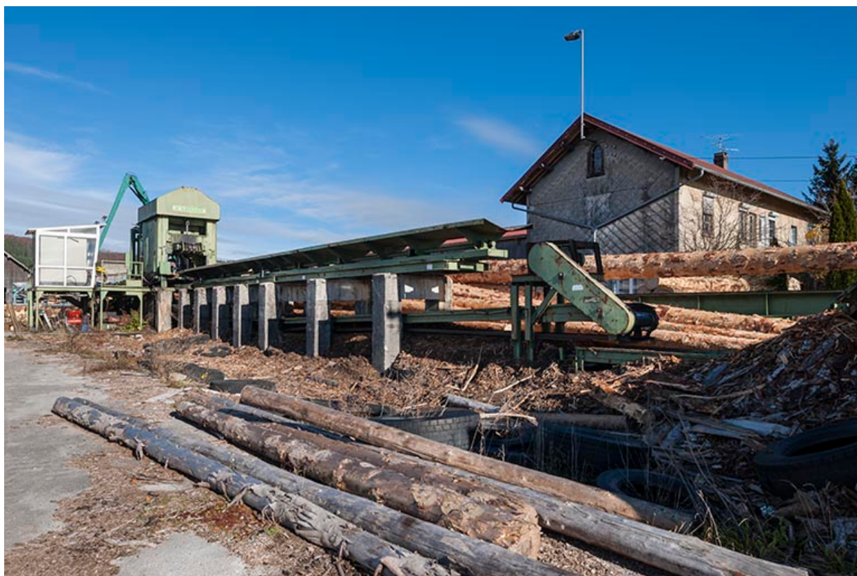
Poste d'écorçage et bureaux.
