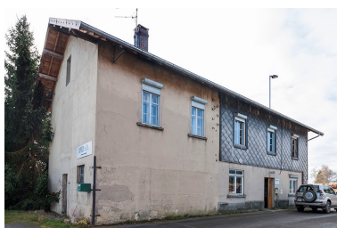
Bureau (et logement). Phot. Jérôme Mongreville IVR43_20152502397NUC4A
