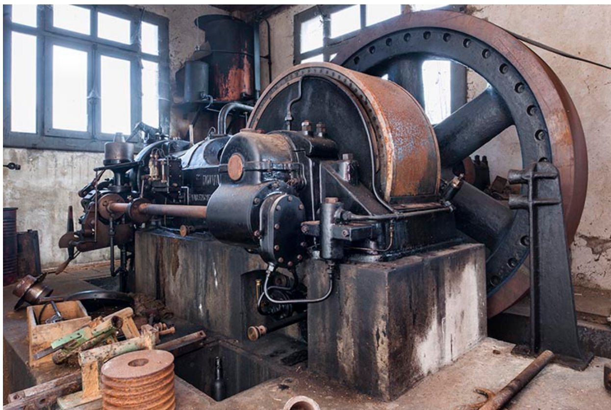
Moteur diesel Duvant.
