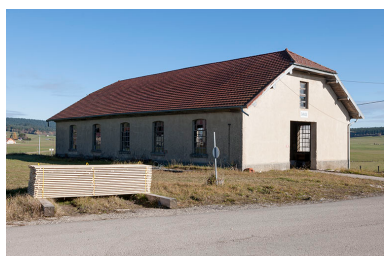
Garage vu de trois quarts. Phot. Jérôme Mongreville IVR43_20152502384NUC4A
