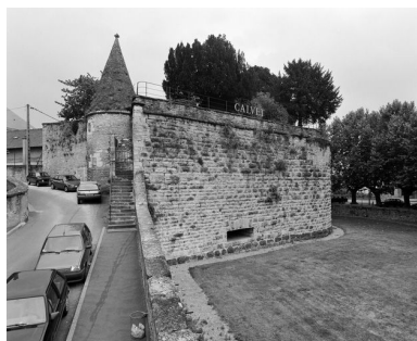
Grosse Tour, appelée aussi bastion Calvet, depuis le rempart Madeleine (1993). Phot. Jean-Luc Duthu IVR26_19932102342X
