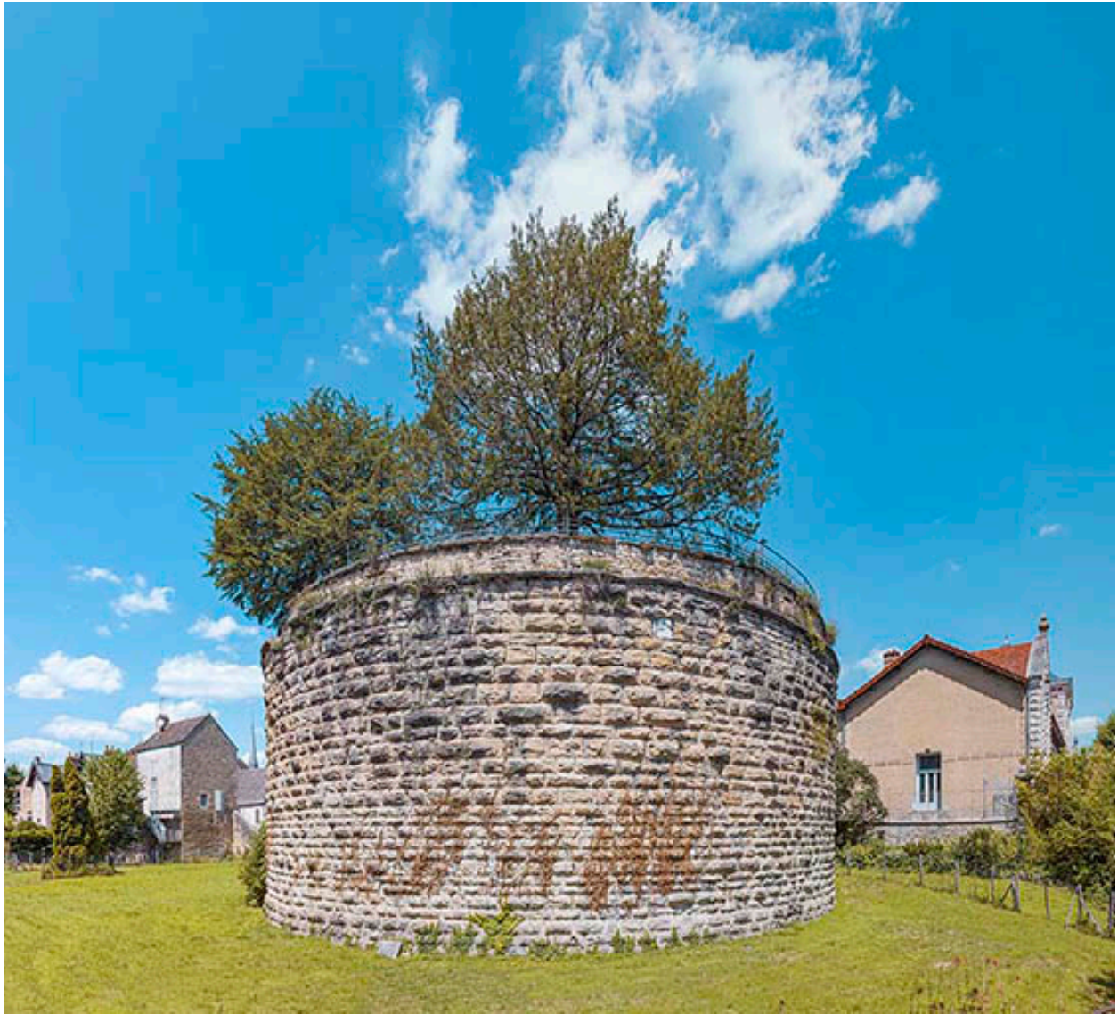
La tour depuis le fossé.
