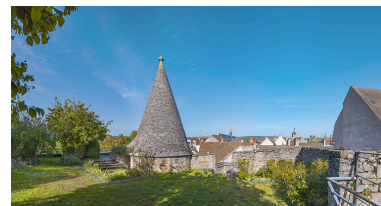
Terrasse de la Grosse Tour et toit conique de la tour des Billes. Phot. Thierry Kuntz IVR26_20232100302NUC4A
