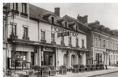
Vue ancienne. Autr. auteur inconnu IVR26_20195800766NUC4A
