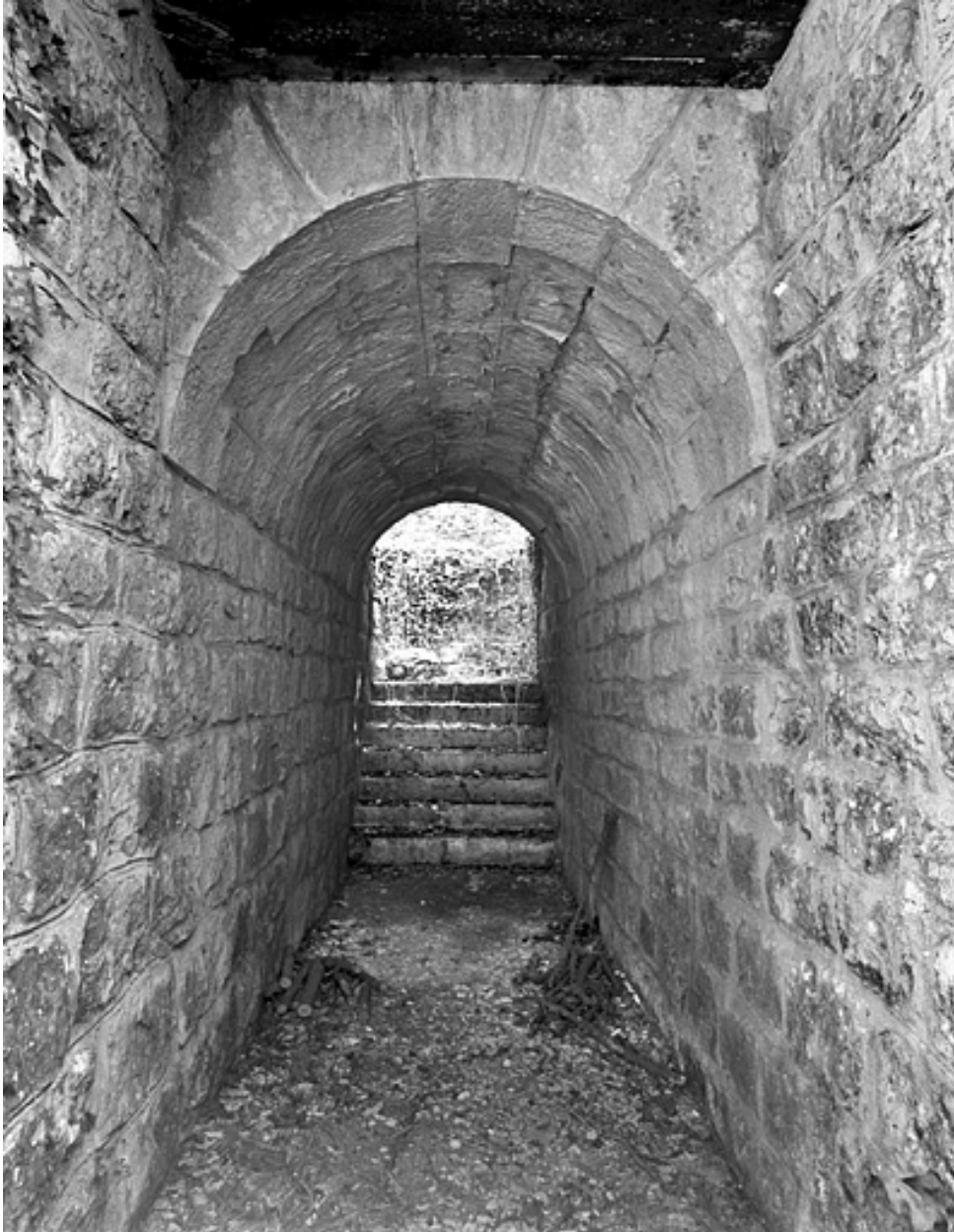
Passage et voûte, depuis l'ouest.
