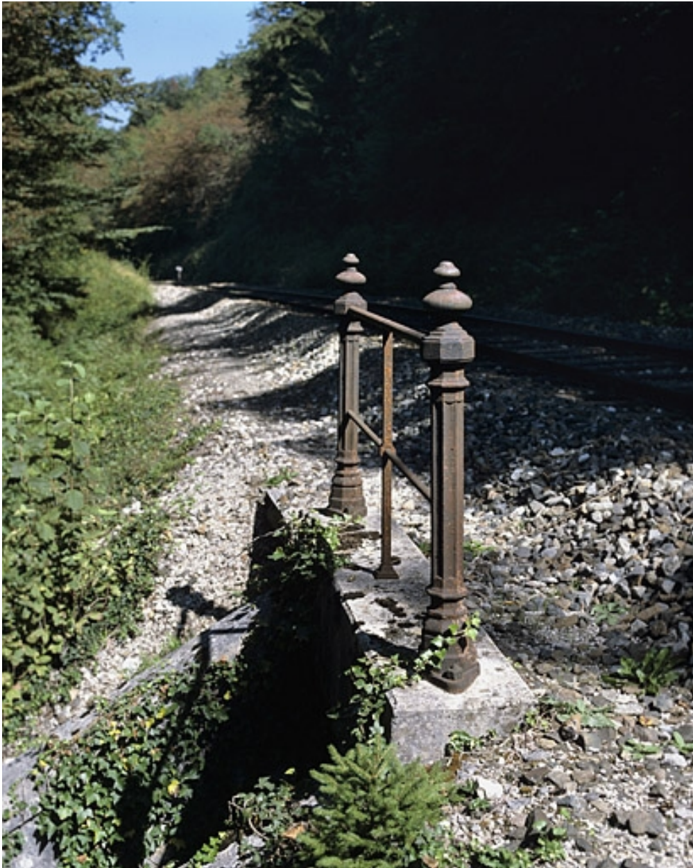
Garde-corps surmontant la tête occidentale.
