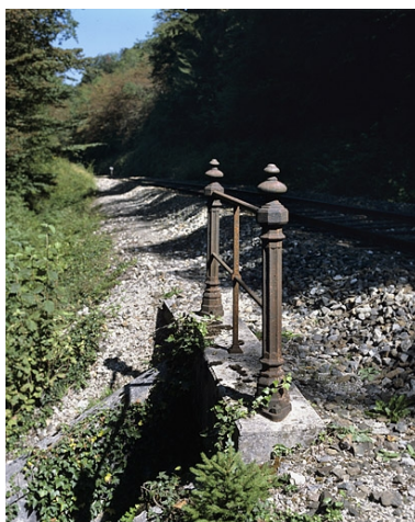
Garde-corps surmontant la tête occidentale. Phot. Yves Sancey IVR43_20050100038XA
