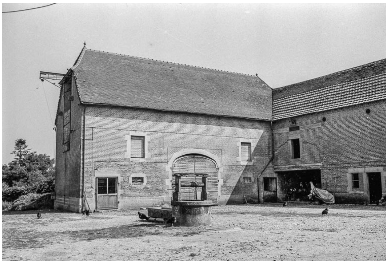
Bâtiment d'exploitation : vue rapprochée..
