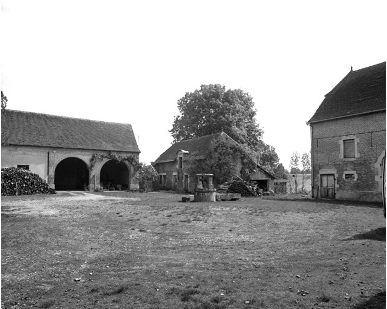
Bâtiments d'exploitation autour de la cour et puits.
