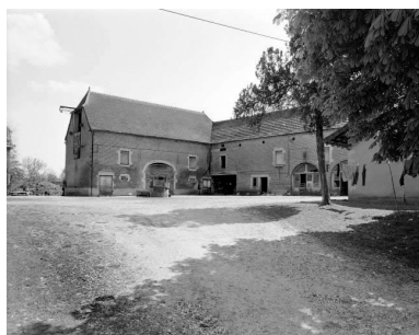
Bâtiment d'exploitation. Phot. Bernard Lardière IVR43_19793900292X
