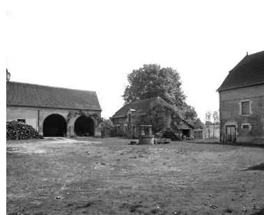
Bâtiments d'exploitation autour de la cour et puits. Phot. Yves Sancey IVR43_19903901116X
