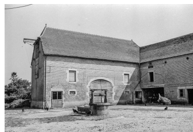
Bâtiment d'exploitation : vue rapprochée.. Phot. Guy Forestier IVR43_19753900135Z
