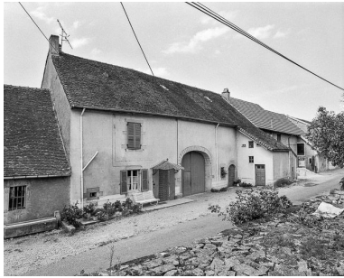
Fermes situées route Principale. Phot. Yves Sancey IVR43_19843900320X
