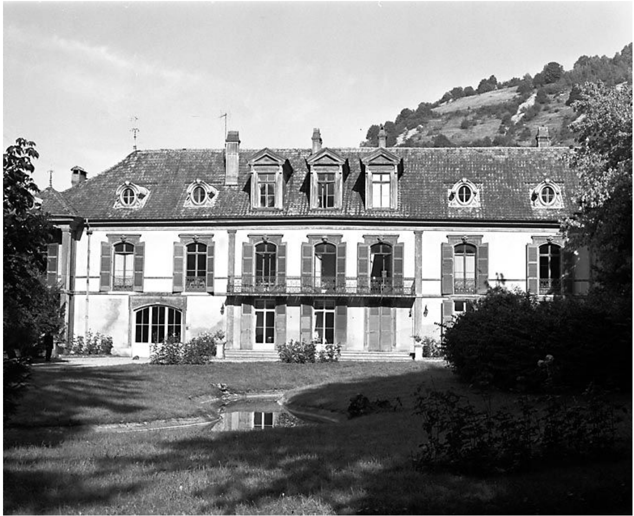
Façade postérieure vue depuis le parc.
