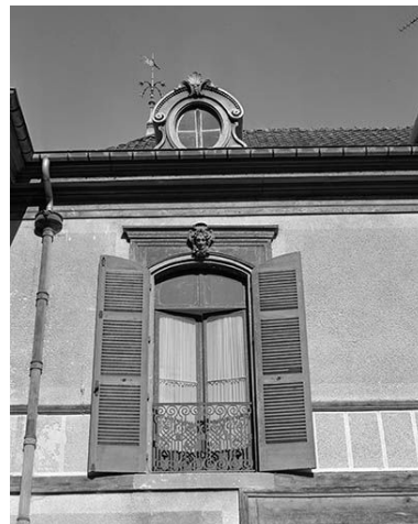
Façade postérieure : une baie du 1er étage. Phot. Yves Sancey IVR43_19802501393X
