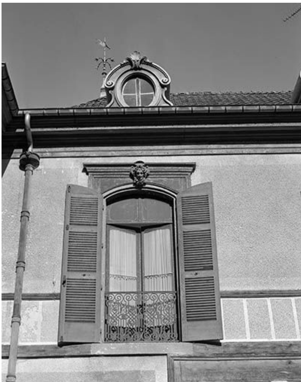
Façade postérieure : une baie du 1er étage.
