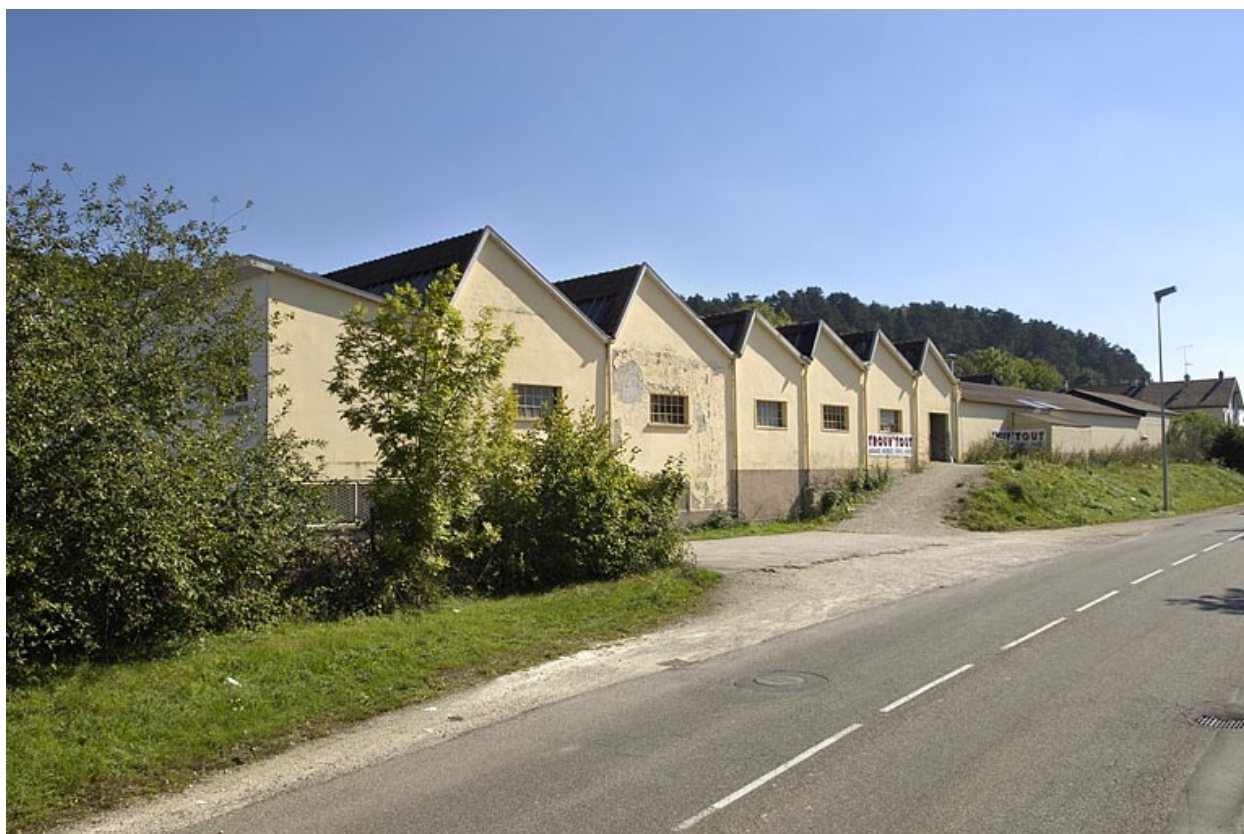
Façade sur rue de l'atelier de fabrication.
