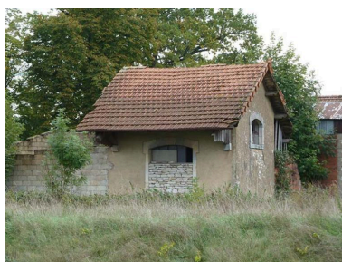
Bâtiment de l'ancienne gare Phot. Sabrina Dalibard IVR43_20137000867NUC2A
