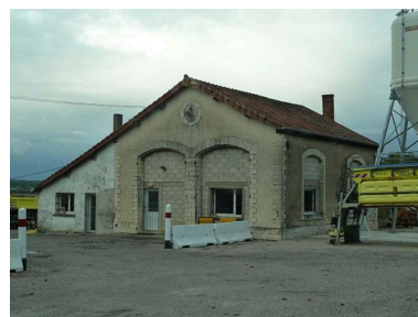
Bâtiment de l'ancienne gare Phot. Sabrina Dalibard IVR43_20137000845NUC2A
