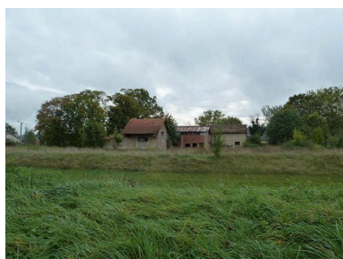
Bâtiments de l'ancienne gare Phot. Sabrina Dalibard IVR43_20137000866NUC2A
