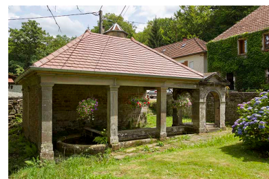
Fontaine-lavoir de la Violette, hameau de la Rochère à Passavant-la-Rochère. Phot. Sonia Dourlot IVR43_20157000709NUC2A
