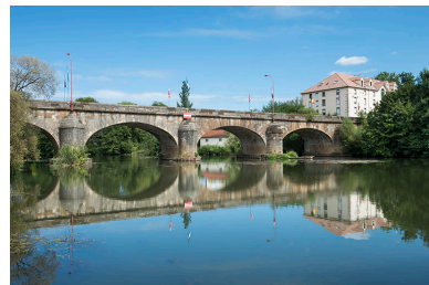
Le pont enjambant la Saône, Port-sur-Saône. Phot. Jérôme Mongreville IVR43_20177001056NUC4A
