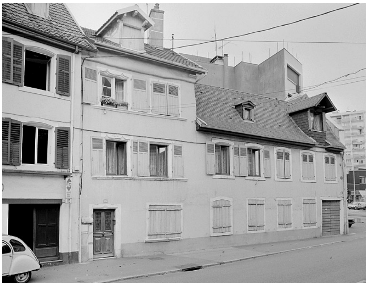
Ensemble des façades sur rue.
