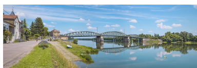
Pont et quai à gradins de Fleurville. Phot. Thierry Kuntz IVR26_20217100524NUC4A
