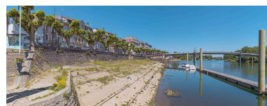
Quai à gradins de Tournus. Phot. Thierry Kuntz IVR26_20217100459NUC4A
