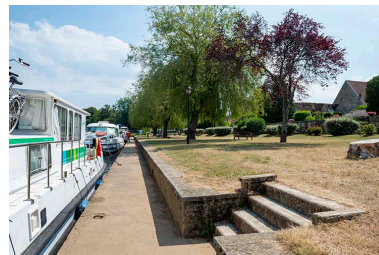
Halte fluviale à Mantoche (70). Phot. Jérôme Mongreville IVR43_20207000233NUC4A
