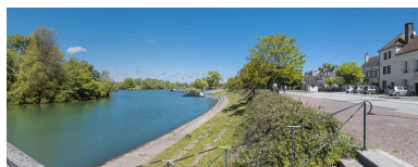
Les quais à gradins de Seurre, avant restauration. Phot. Thierry Kuntz IVR26_20172100257NUC4A
