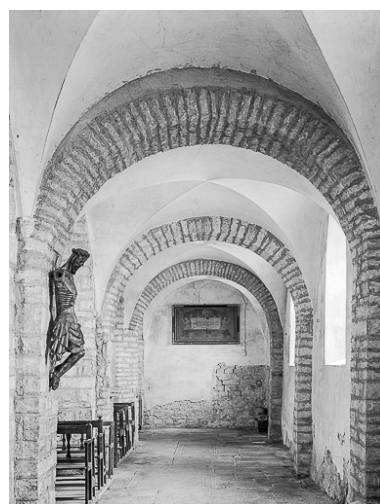
Intérieur : bas-côté gauche. Phot. Yves Sancey IVR43_19753900012V
