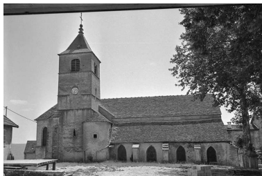
Façade latérale droite. Phot. Guy Forestier IVR43_19743900656Z
