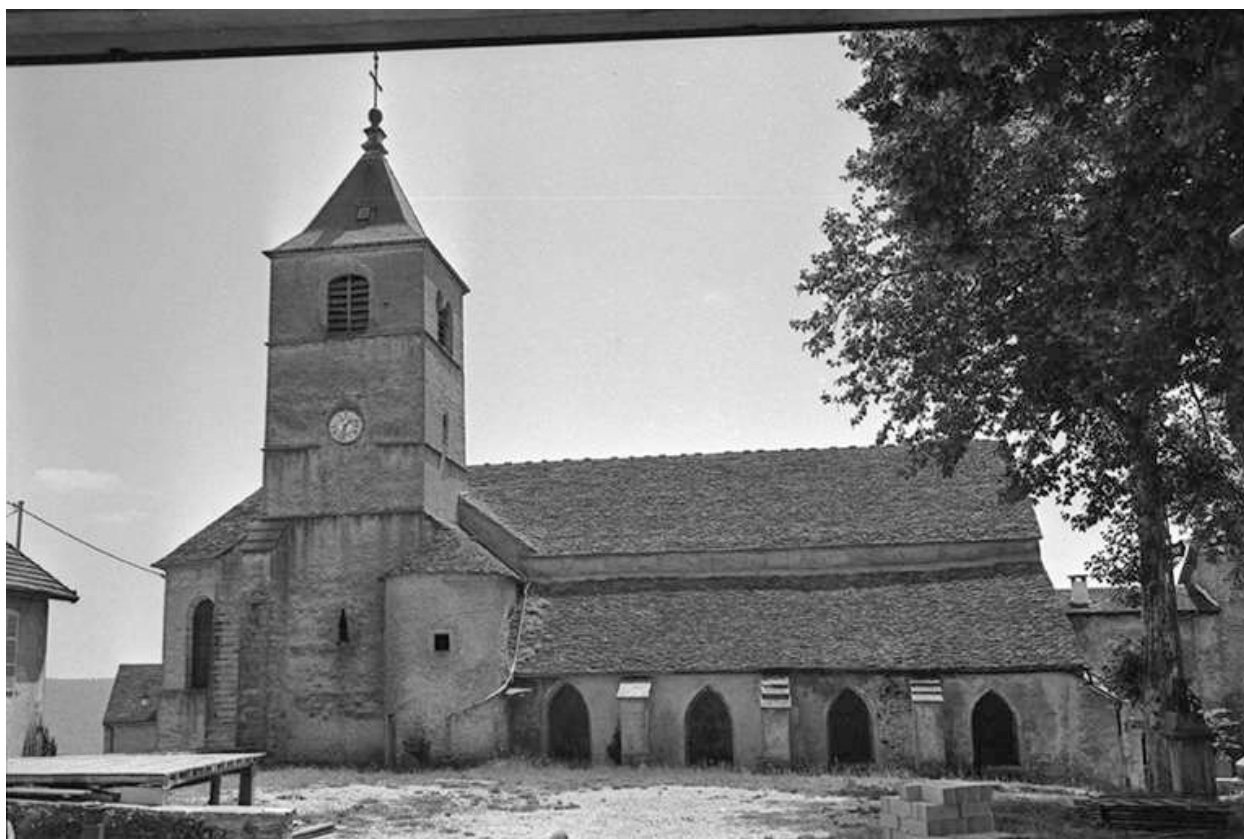
Façade latérale droite.
