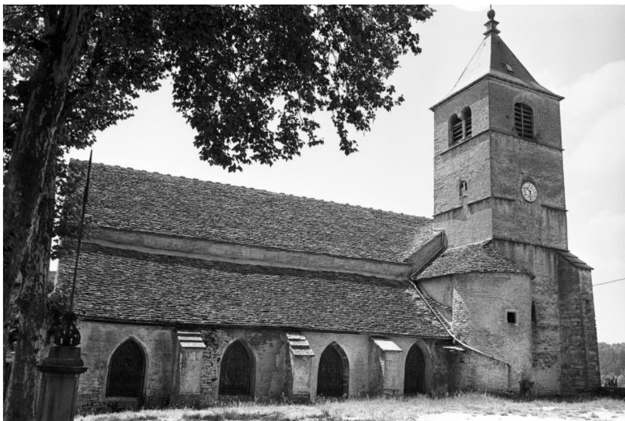
Façade latérale gauche.
