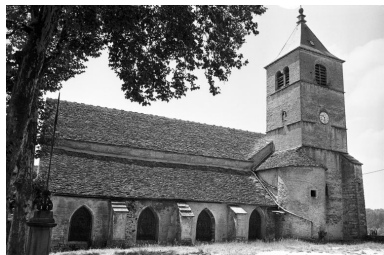
Façade latérale gauche. Phot. Guy Forestier IVR43_19743900681Z
