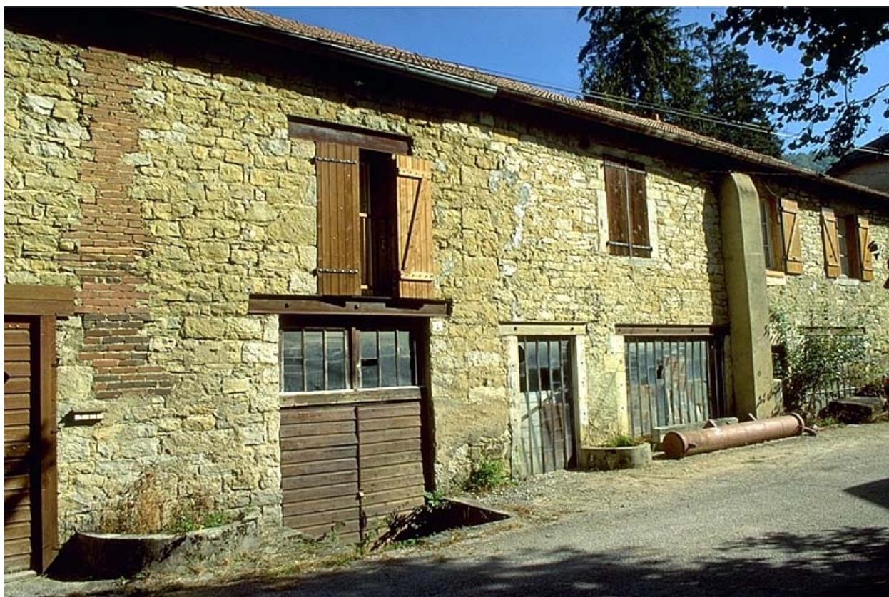
Façade antérieure de l'atelier de fabrication.
