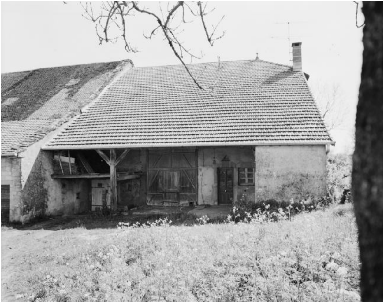
Ferme située rue des Sétrettes : façade antérieure.
