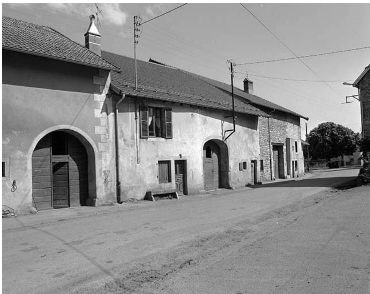
Ferme située rue du Château : vue de trois quarts gauche.
