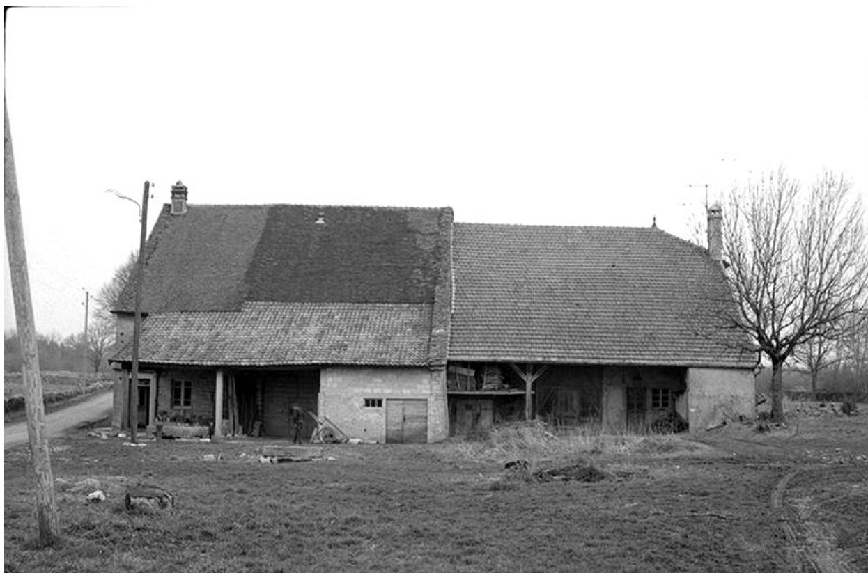
Ferme cadastrée 1940 B4 401-402 située le long du chemin vicinal ordinaire n° 4, datée de 1864 (?) : vue d'ensemble.
