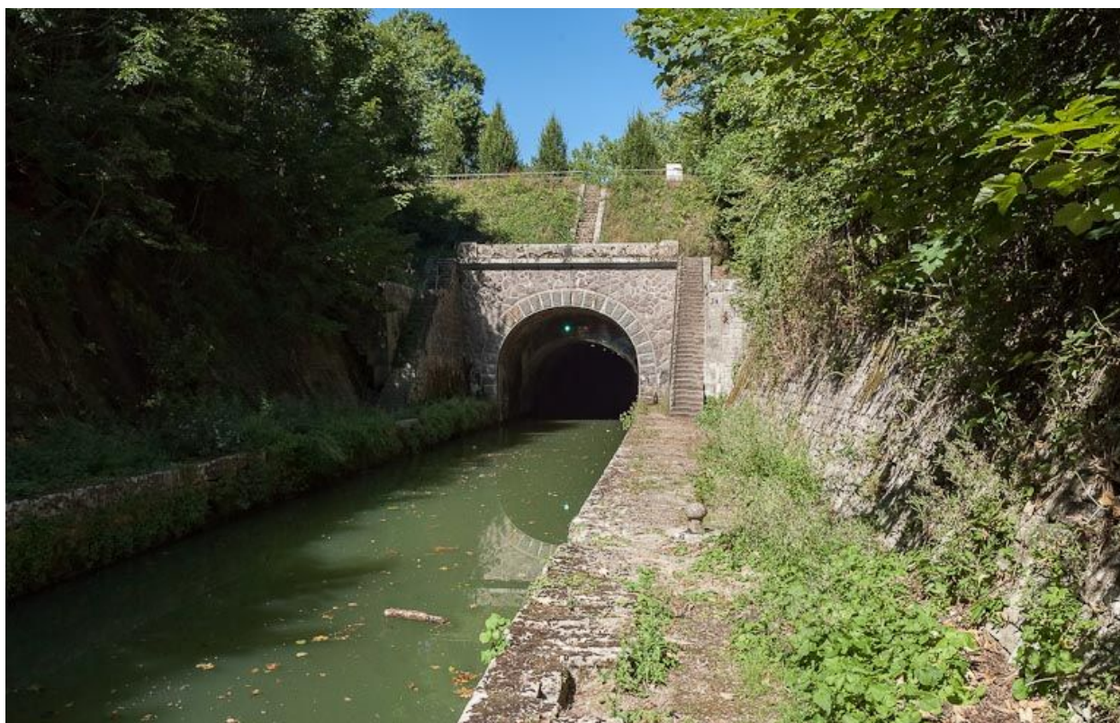
Vue de l'entrée du tunnel à Créancey.
