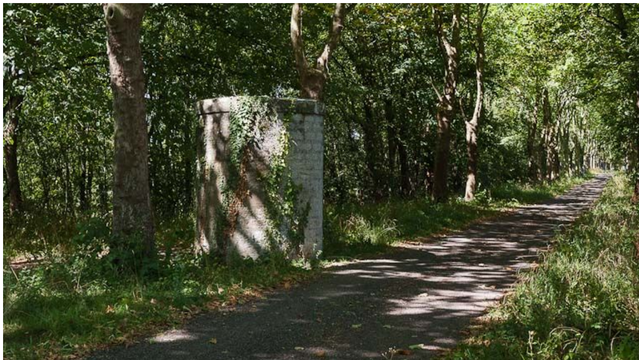
Vue d'un puits d'aération du tunnel.
