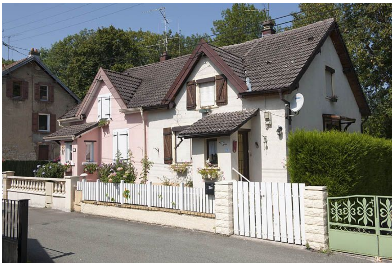
Maison jumelée rue des Campenottes.
