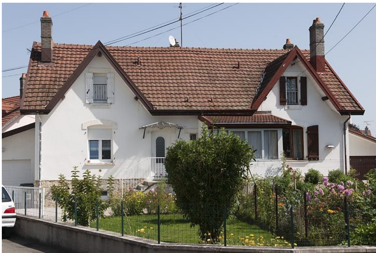
Maison jumelée. Vue de face.
