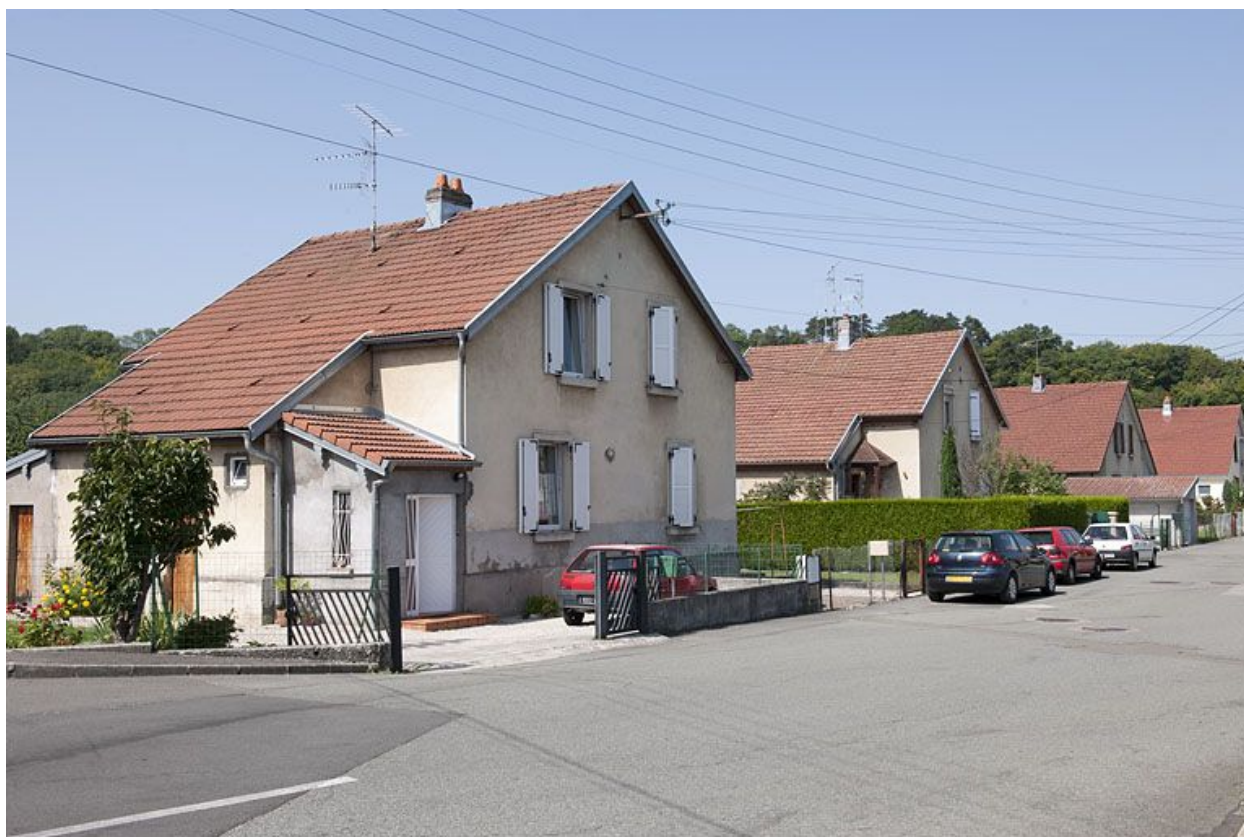
Maisons jumelées rue des Pâquerettes.
