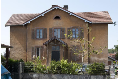
Façade antérieure de l'école. Phot. Jérôme Mongreville IVR43_20112502207NUC4A
