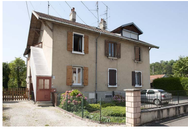
Habitation à trois ou quatre logements. Phot. Jérôme Mongreville IVR43_20112502218NUC4A
