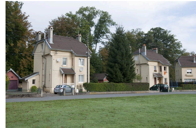
Logements de cadres (?). Phot. Jérôme Mongreville IVR43_20122501850NUC4A
