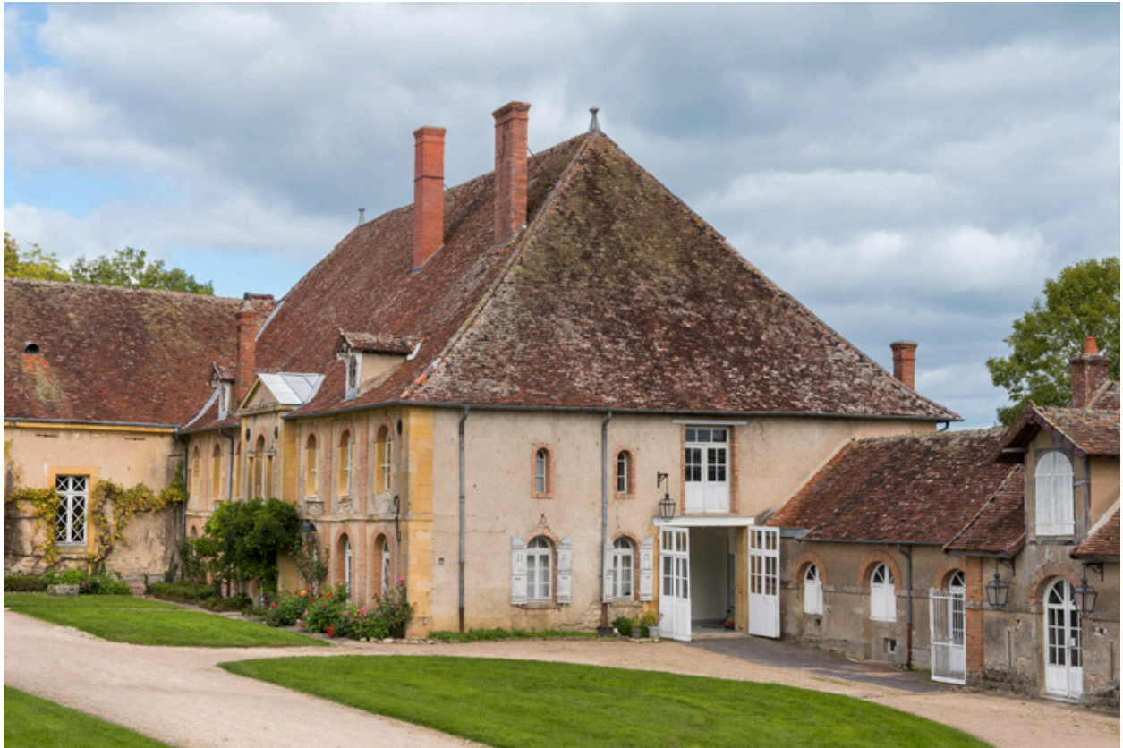
Façades antérieure et latérale droite.
