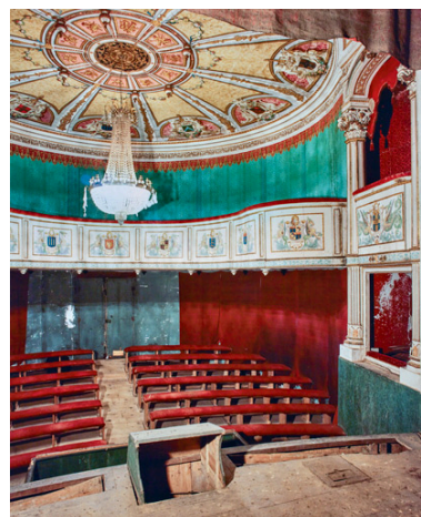
Salle, vue depuis la scène (de trois quarts), en 1996 avant restauration. Phot. Michel Rosso IVR26_19967100733XA
