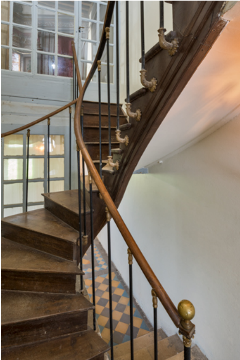
Couloir : escalier menant au balcon (volée de droite) et à une pièce côté rue (à gauche).
