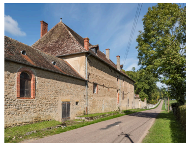
Façade postérieure (côté route), de trois quarts gauche. Phot. Pierre-Marie Barbe-Richaud IVR26_20257101073NUC4A
