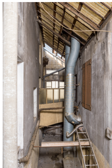
Cour couverte entre le café (à gauche) et le troisième corps de bâtiment (à droite), à usage de bureaux. Phot. Pierre-Marie Barbe-Richaud IVR26_20257100984NUC4A
