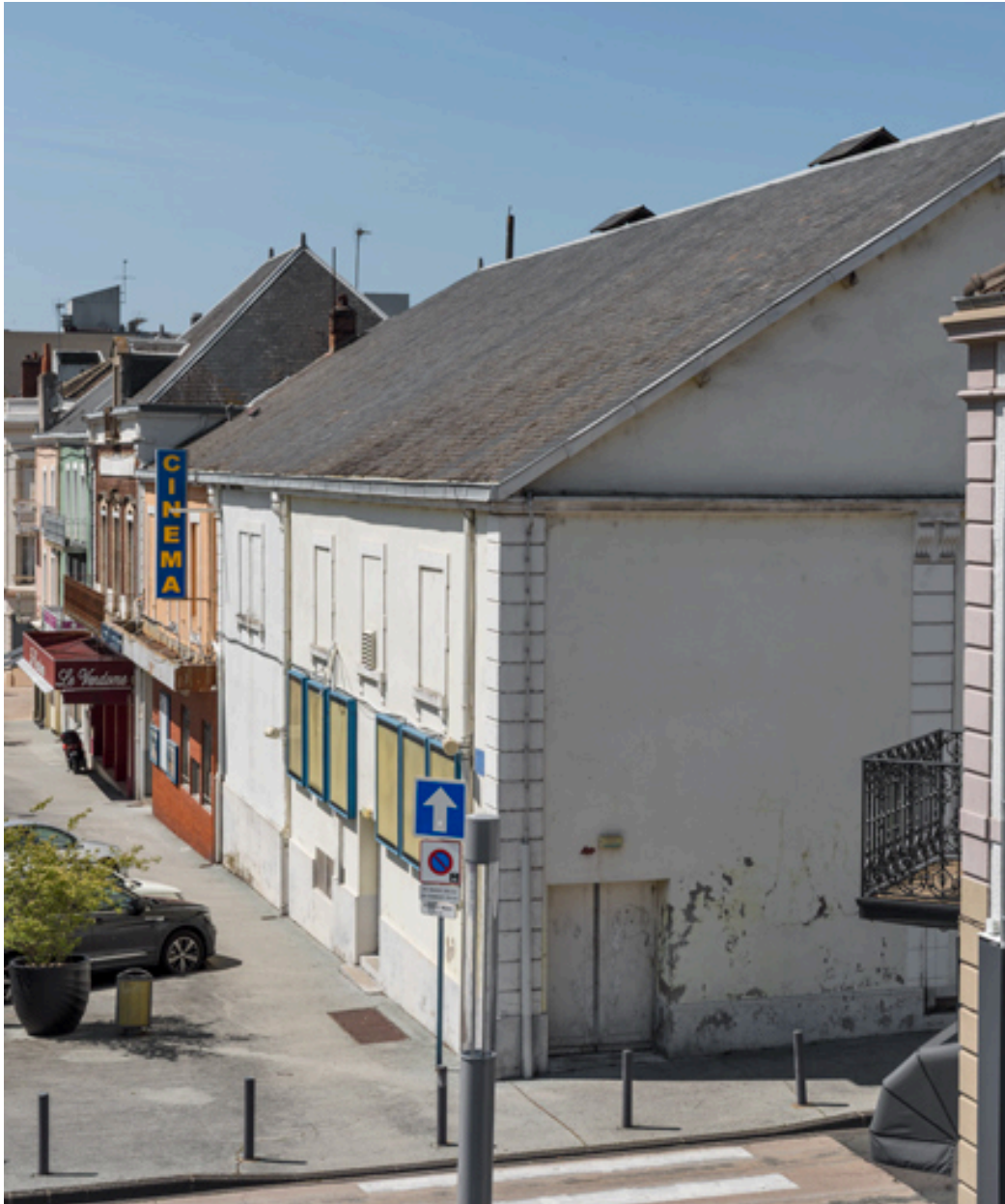
Vue d'ensemble en enfilade, depuis le pont enjambant la voie ferrée.
