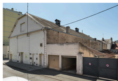
Cinéma : façades postérieure et latérale droite. Phot. Pierre-Marie Barbe-Richaud IVR26_20257100883NUC4A
