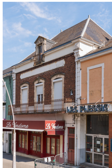
Café : façade antérieure, de trois quarts droite. Phot. Pierre-Marie Barbe-Richaud IVR26_20257100981NUC4A
