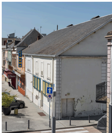
Vue d'ensemble en enfilade, depuis le pont enjambant la voie ferrée. Phot. Pierre-Marie Barbe-Richaud IVR26_20257100882NUC2A
