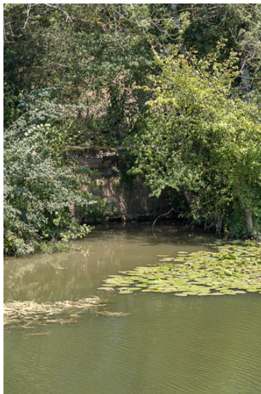
Vue du ponceau. Phot. Pierre-Marie Barbe-Richaud IVR26_20187100300NUC4A
