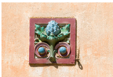
Détail de céramique sur la façade. Phot. Sonia Dourlot IVR43_20157000316NUC2A
