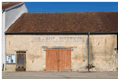
Entrepôt au 35 Grande Rue. Phot. Sonia Dourlot IVR43_20157000310NUC2A
