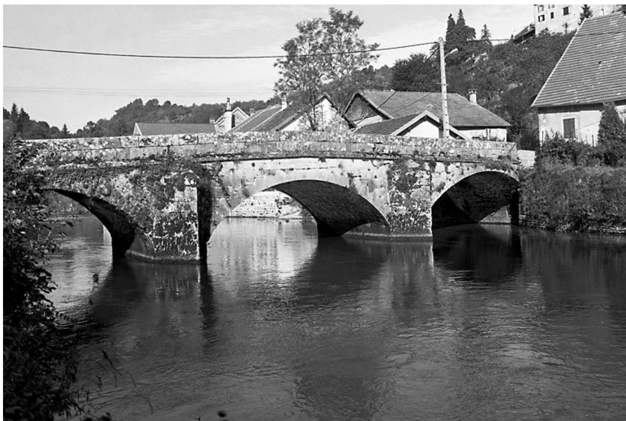
Vue depuis l'amont.
