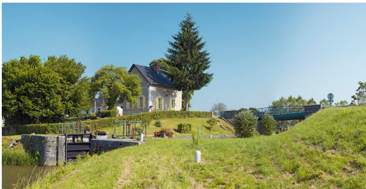
Pont sur l'écluse.
