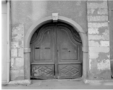
Porte cochère sur la rue de la Sous- Préfecture. Porte percée en 1667 et garnie d'une menuiserie du 18e siècle. Phot. Jérôme Mongreville IVR43_19872500440X
