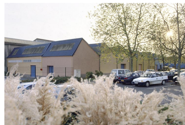
Murs-pignons nord de l'atelier de filature. Phot. Jérôme Mongreville IVR43_20019000608ZA
