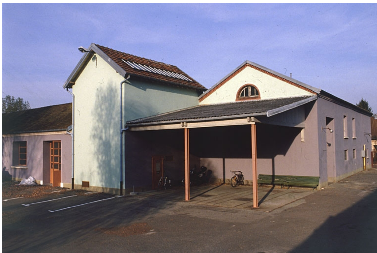
Chaufferie et atelier de forge.
