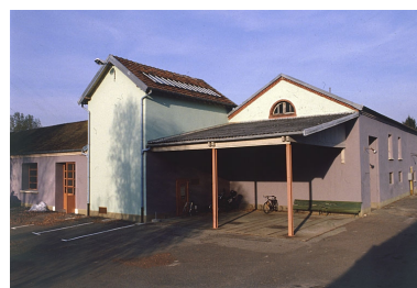
Chaufferie et atelier de forge. Phot. Jérôme Mongreville IVR43_20019000616ZA
