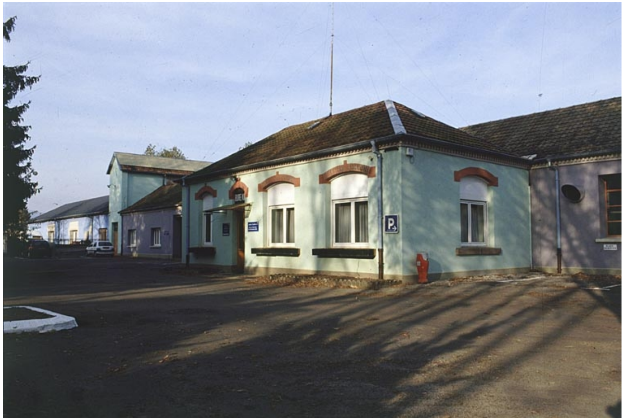
Façade antérieure de l'usine.
