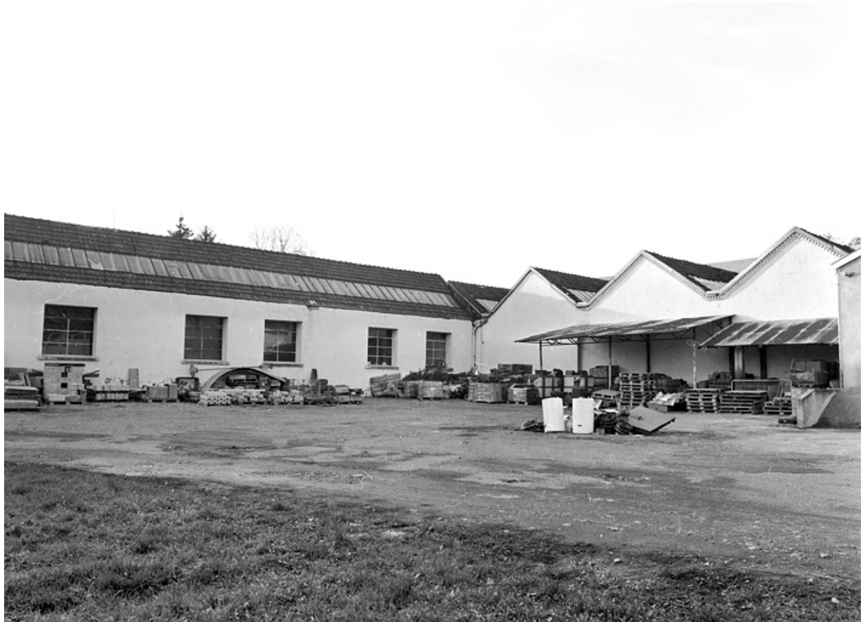
Façades arrière depuis la cour.
