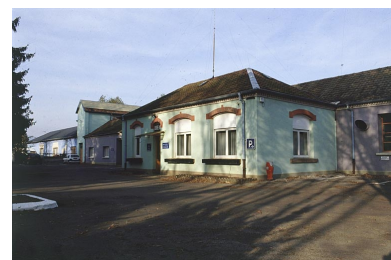
Façade antérieure de l'usine. Phot. Jérôme Mongreville IVR43_20019000610ZA
